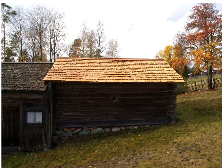
2020-10-08: Slutbesiktning Vedboden med nytt spåntak och nya nockbrädor.
