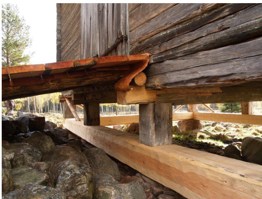
2020-10-08 : Slutbesiktning Ny uppkörsbro. Kärnan har vänts uppåt.
