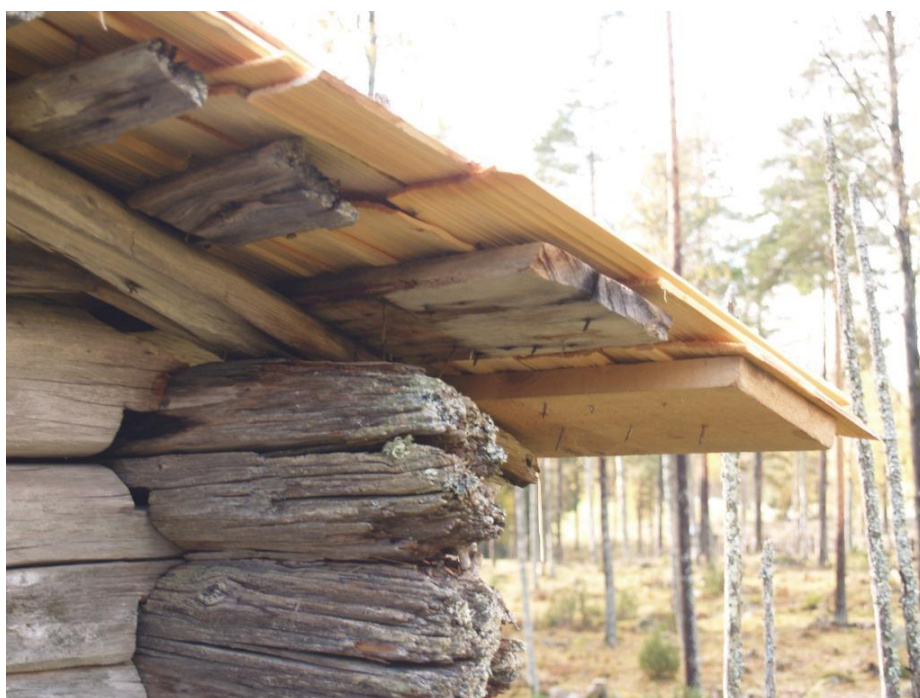
2020-10-08: Slutbesiktning I norra hörnet är spånet utdraget längre för att täcka den utskjutande knutkedjan. Trobrädan längst ned i takfoten har till del bytts ut och förlängts.
