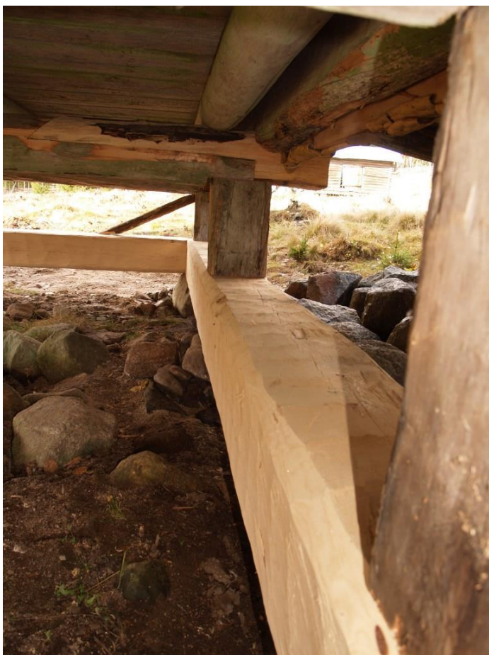
2020-10-08 : Slutbesiktning Skarv i bärlina.
