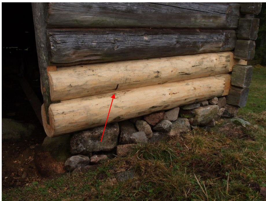
2020-10-08 : Slutbesiktning Vägstockarna D1 och D2 har bytts ut. Stengrunden har staplats om. I D2 syns järnstagets infästning.
