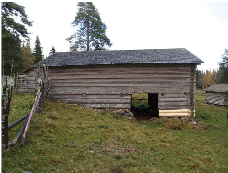
2020-10-08: Slutbesiktning Långsida D efter åtgärd.
