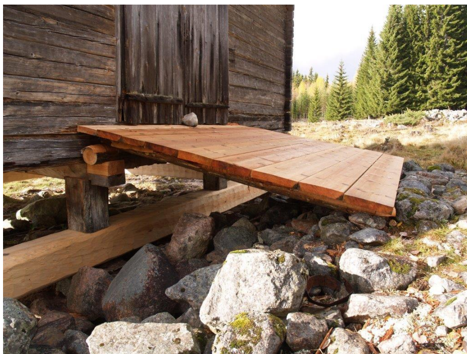
2020-10-08 : Slutbesiktning Stenraden närmast syllramen har rensats så att inget ska ligga mot virket.
