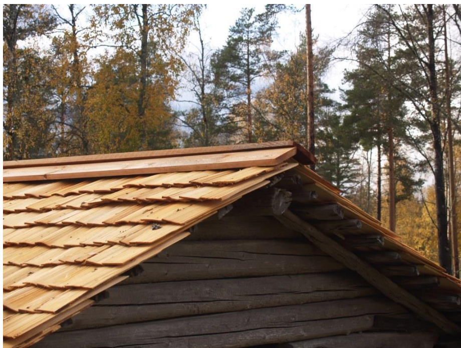
2020-10-08: Slutbesiktning Nya nockbrädor.
