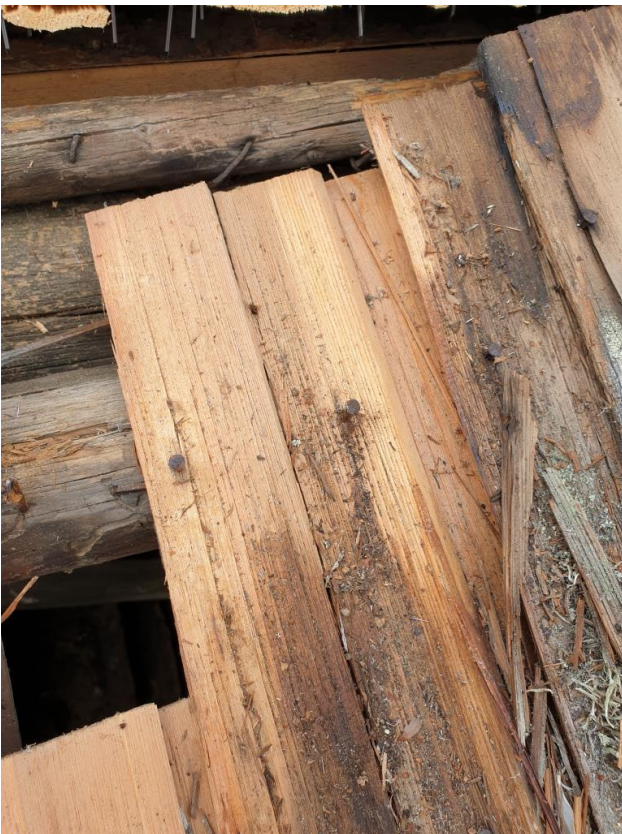
2022-09-09: Spänen är spikade med 2 ½ tum lång trådspik.
