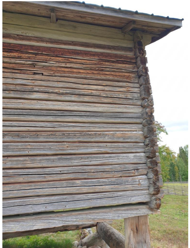
2022-09-09: Urtagen på utsidan visar att de släta stockarna är återanvända från en äldre stomme.
