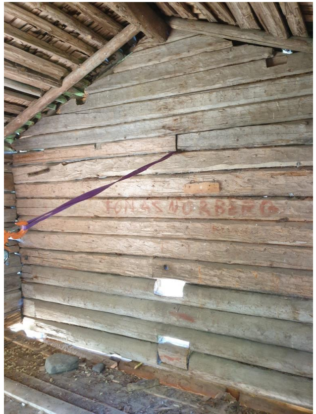
2022-08-24: När boden tömts blev insidan synlig. Det är delar från flera stommar som har återanvänts.
