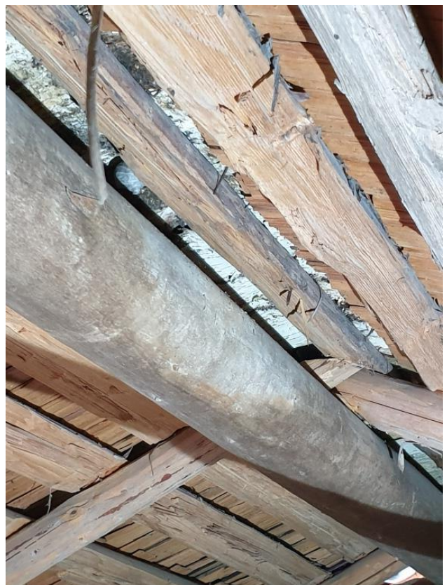
2022-09-09: Ovan nocken ligger näver som tätning. Spånen är handspäntade och spikade med smidd spik eller klippspik.
