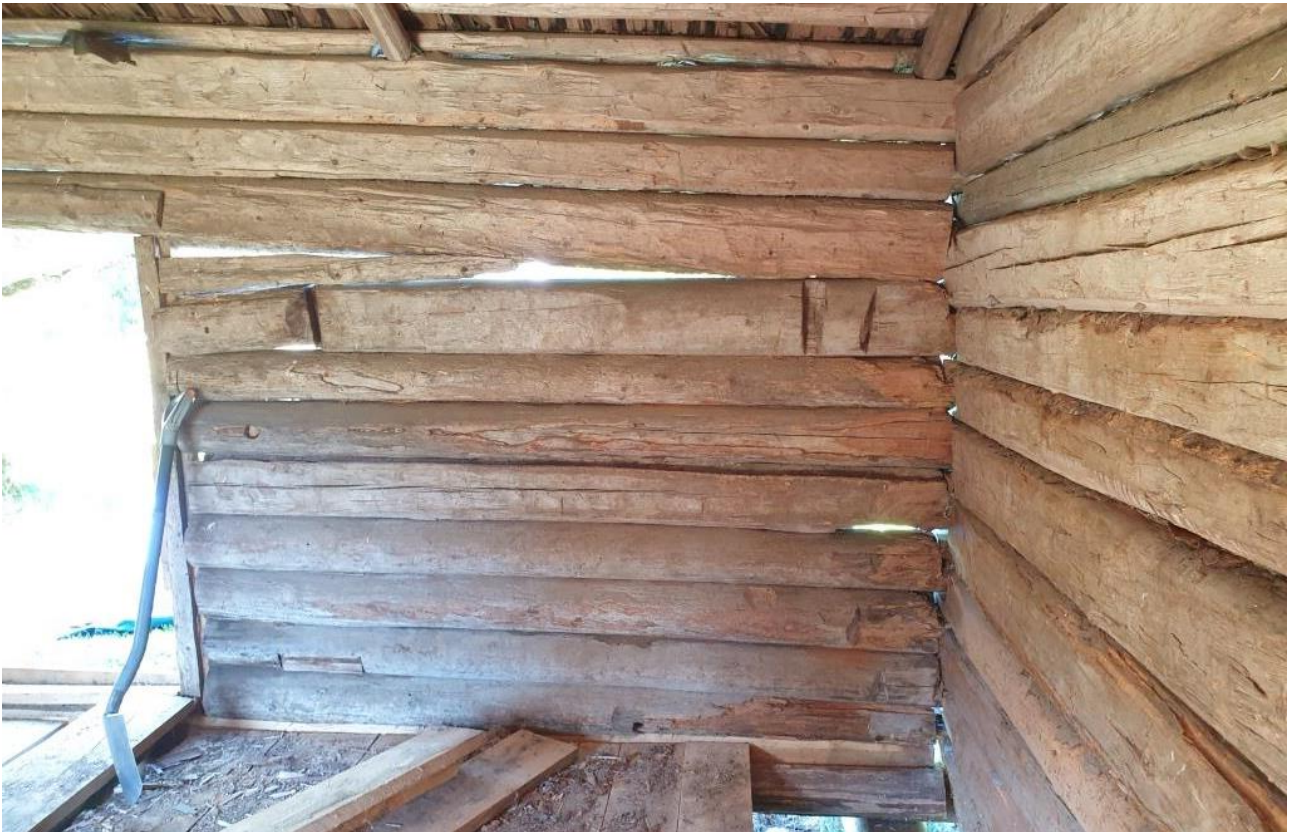
2022-08-24: Vi beslöt att följarnas insida skulle anpassas så att rundtimmerstockarna fick ha kvar sin rundning inåt. Det är svårt att få tryck mot följaren annars eftersom det är både rundtimmer och bilat timmer.
