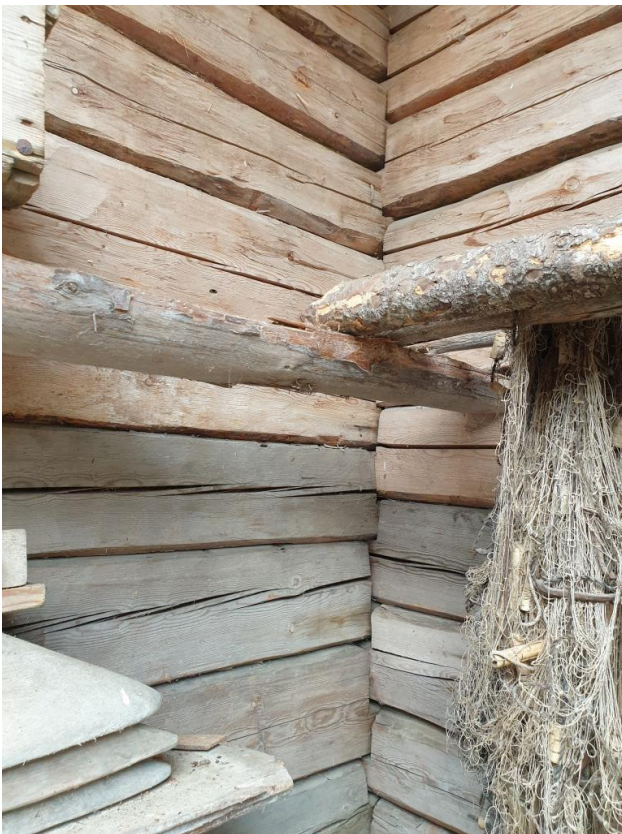
2022-09-10: Kulören på timret visar skillnaden mellan äldre och senare tillkommet timmer.
