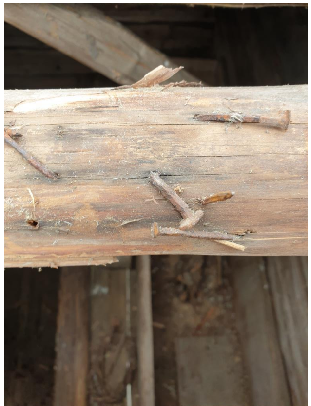
2022-09-09: I spånläkten finns äldre spik kvar från det spån som lades innan 1970-talet. Spiken berättar att vi nu spikar den tredje omgången spån på härbret (troligen nävertak innan dess).
