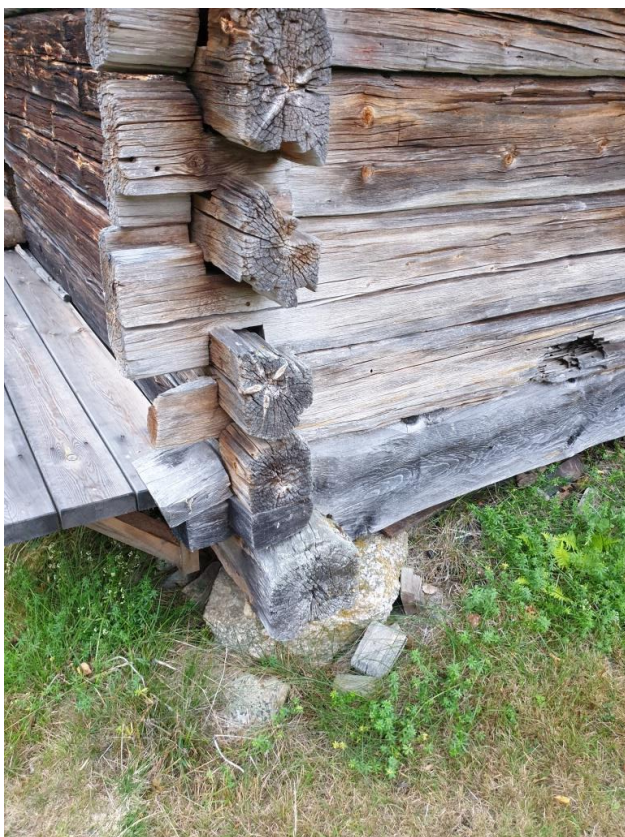
2021-09-28: Knutarna är svaga, delvis eftersom det är äldre timmer som har huggits om och återanvänts.
