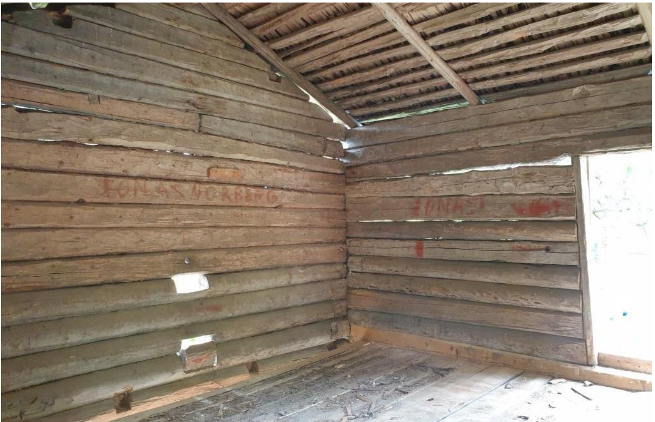
2022-09-09: Slutbesiktning Vy mot hörn BC efter lyft och riktning.
