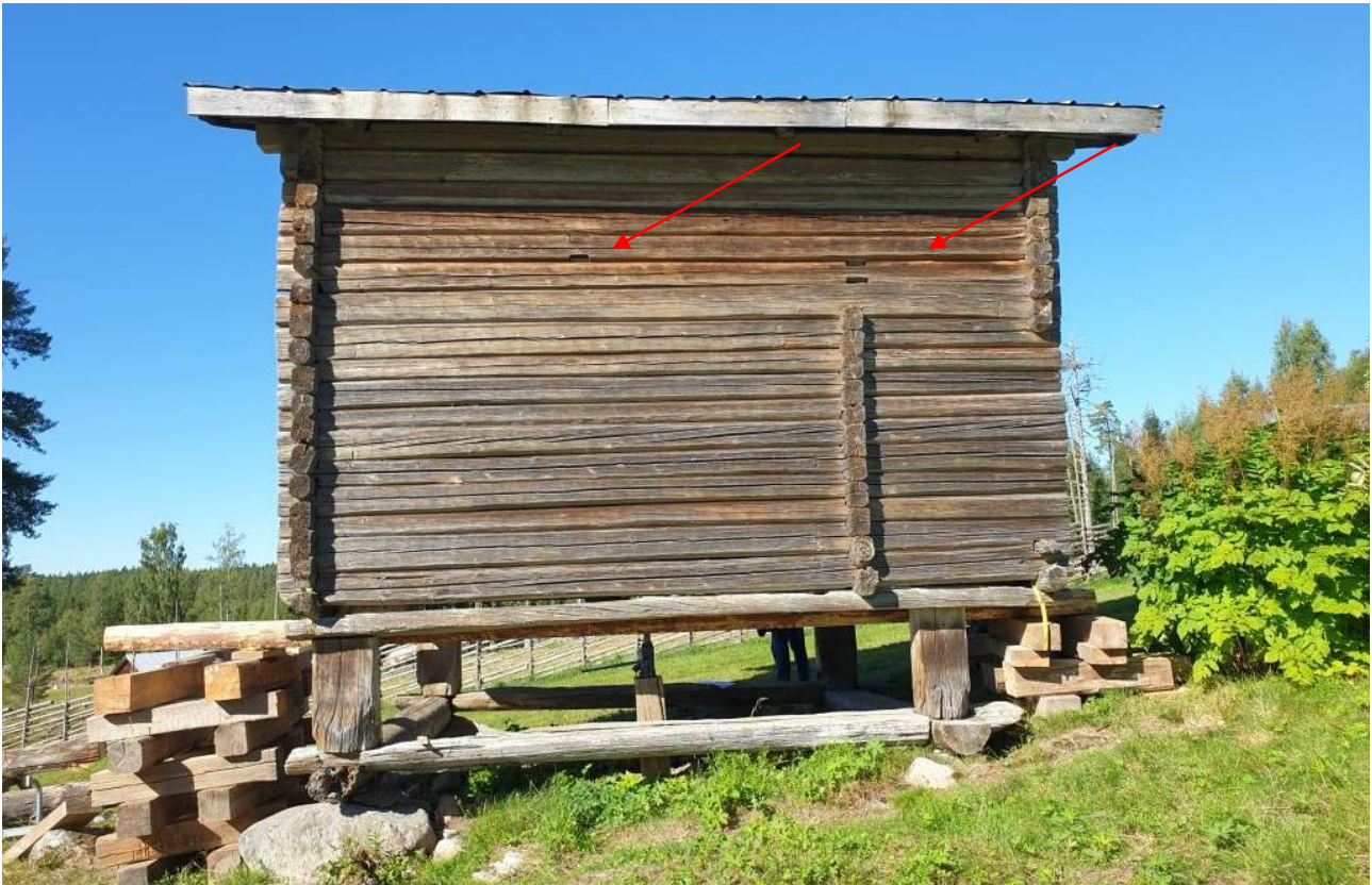
2022-08-24: Härbret är lokaltypiskt och har aldrig riktigt fått någon uppmärksamhet. Återanvänt virke berättar att byggnaden är höjd och på insidan syns det tydligt att fyra timmervarv är senare tillkomna.
