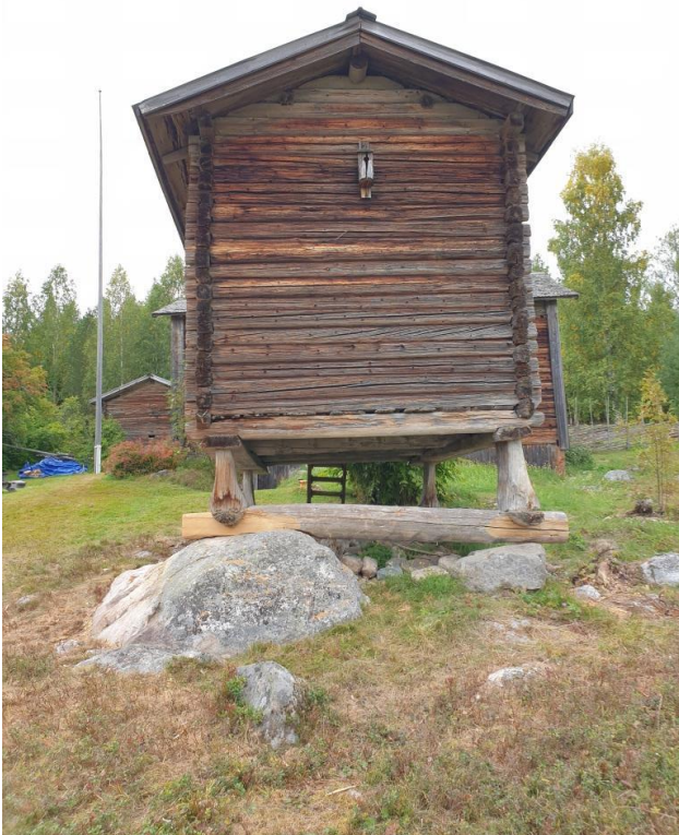
2022-09-09: Slutbesiktning Böjningen, "kuven", på stocken passade bra med anläggningen mot stenen.
