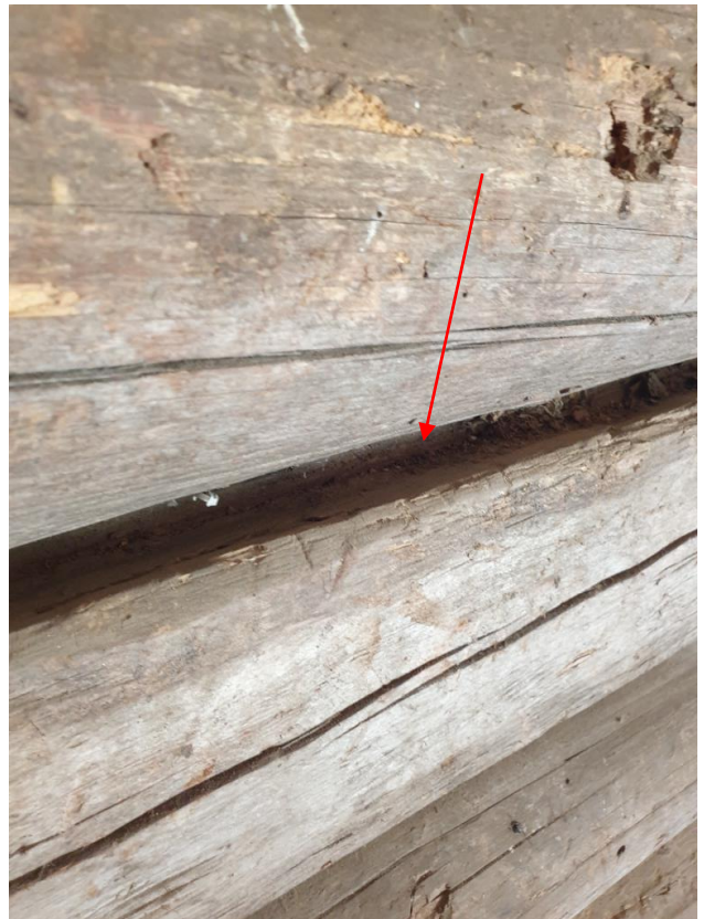
2022-08-24: Vägstock som varit väggband med fals för nävertak.
