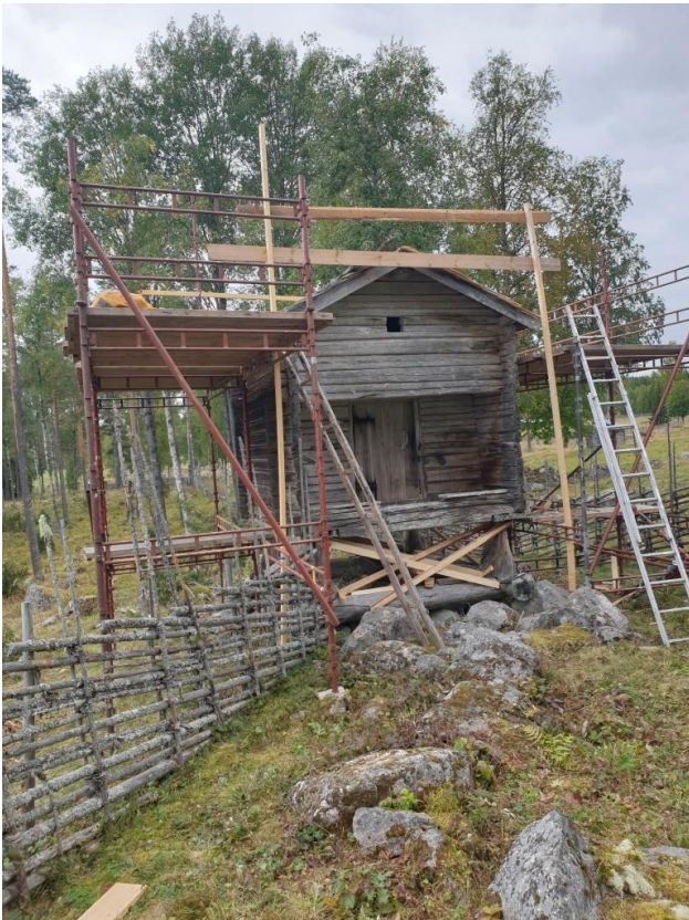
2022-09-09: Härbrets ena sida är omlagd medan arbetet med den andra ska påbörjas. Det nya maskinspantade granspånnet ligger i buntar. Det behöver inte blötas, utan är färskt nog att spikas utan att spricka.
