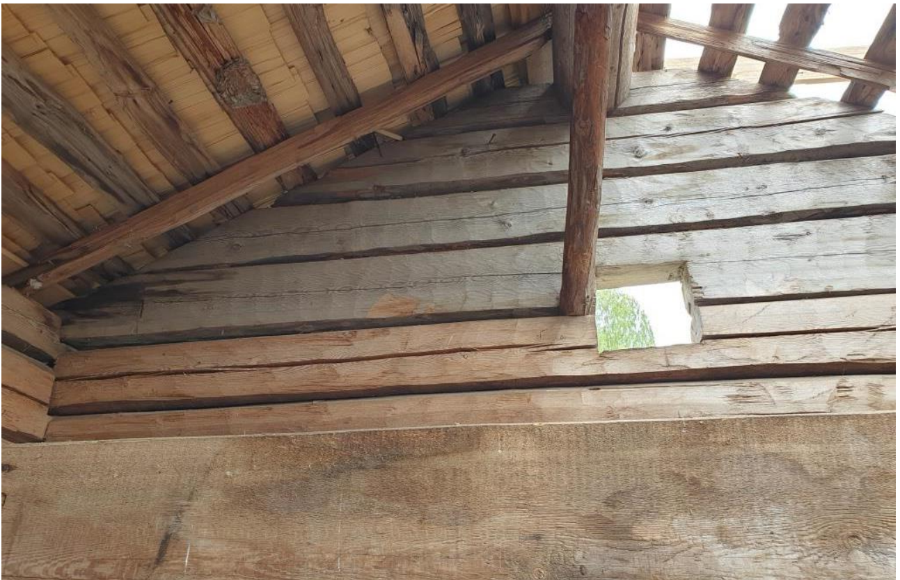
2022-09-10: Invändigt går det se att härbret har höjts ett antal timmervarv.
