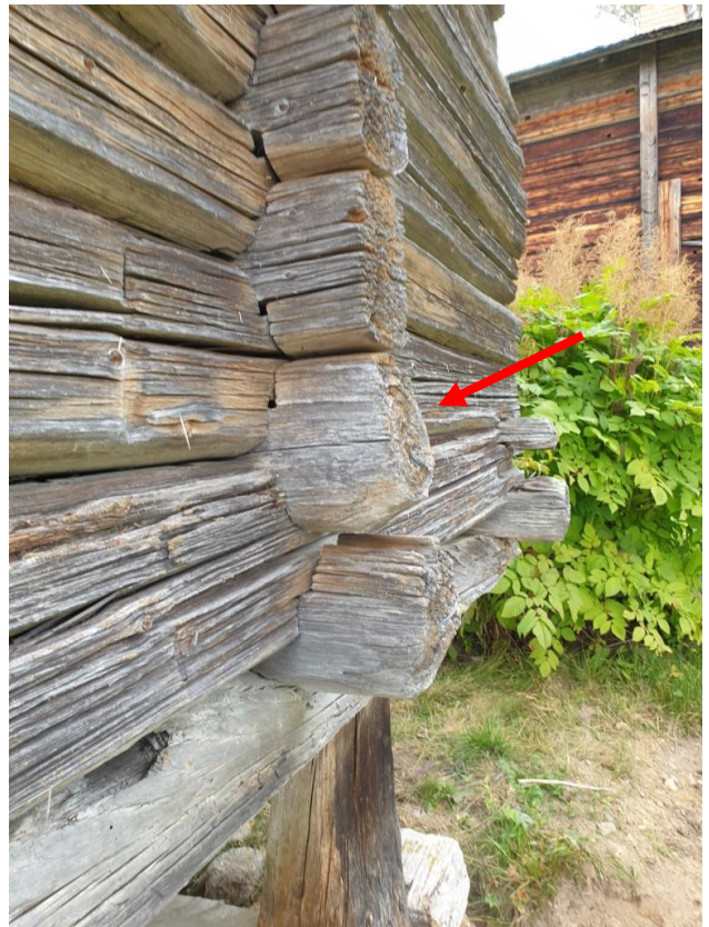
2022-09-09: Utsvängd form på knutskallen på B2 men inte den koniska form som kan ses på äldre stommar.
