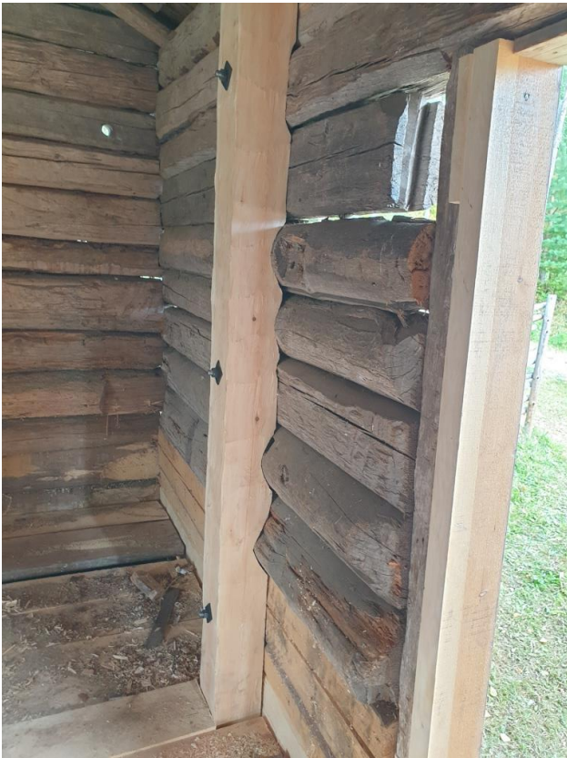
2022-09-09: Slutbesiktning Följare mot hörn DA. Den sågade brädan (öppningens gåt) byttes ut.
