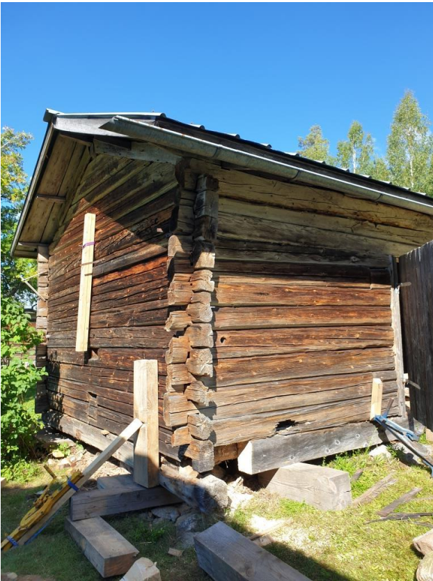
2022-08-24: Pågående arbete med vedboden. Tryck och mothåll för att kunna rikta den.
