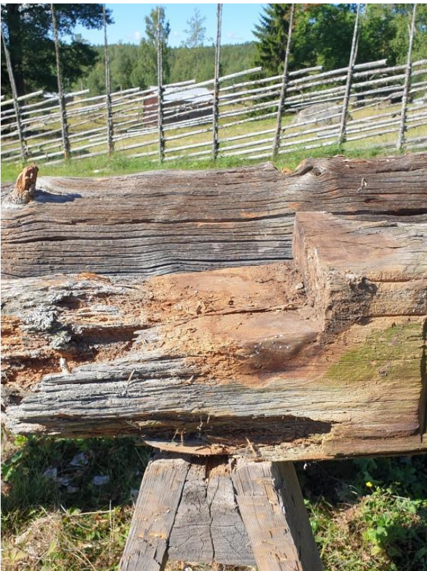
2022-08-24: Syllramen har enkla knutar utan låsning med klack.
