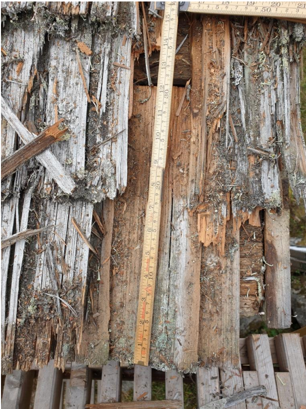
2022-09-09: Takfoten har ett två tredjedelars spån i botten.
