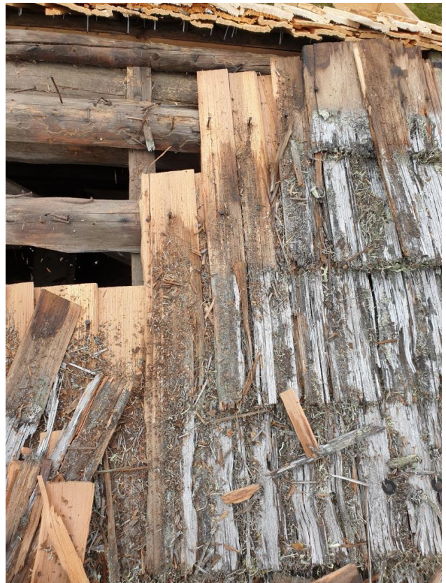
2022-09-09: Spänen ligger med trelagstäckning.
