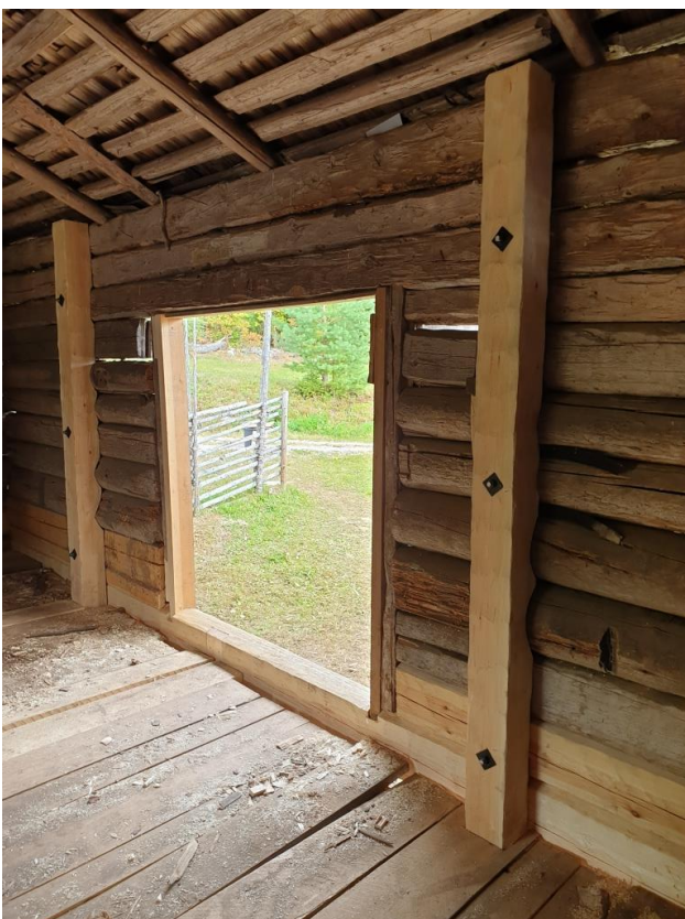
2022-09-09: Slutbesiktning Invändiga följare på var sida om ingången på långsidan A.
