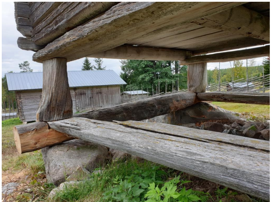
2022-09-09: Slutbesiktning Den nya syllramen vilar mot befintlig grundsten. Anliggningsytan är så liten som möjligt för att virket inte ska suga upp den fukt som rinner på stenens plana ovansida.
