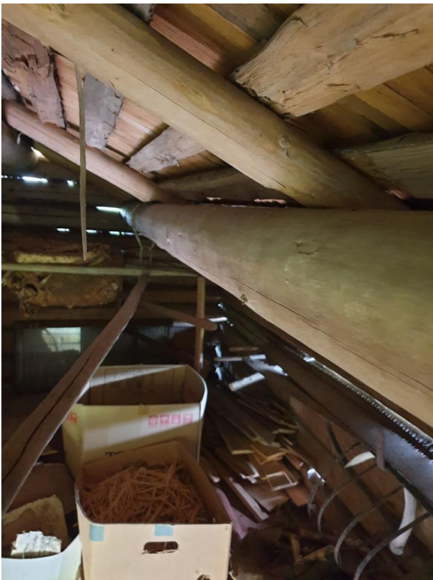
2022-09-09: Övervåningen har extraordinärt släta takåsar och sparrar. En ås har mer bark men det är en rotstock och bakom föremålen syns skärning för savbarkning.
