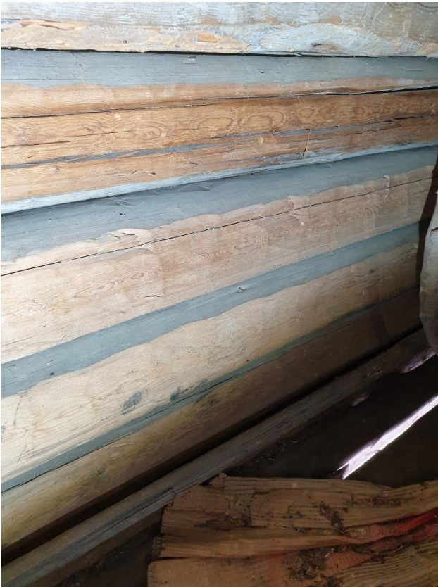
2022-09-09: Höjningen på övervåningen har gjorts med fyra varv. Dessa stockar är släta precis som takåsarna.
