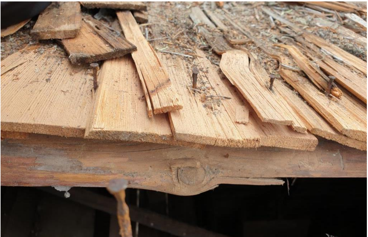
2022-09-09: Törrakespån är nästan rektangulära. Majoriteten låg med kärnan som överlappade ytveden. Knivsidan var vänd uppåt.
