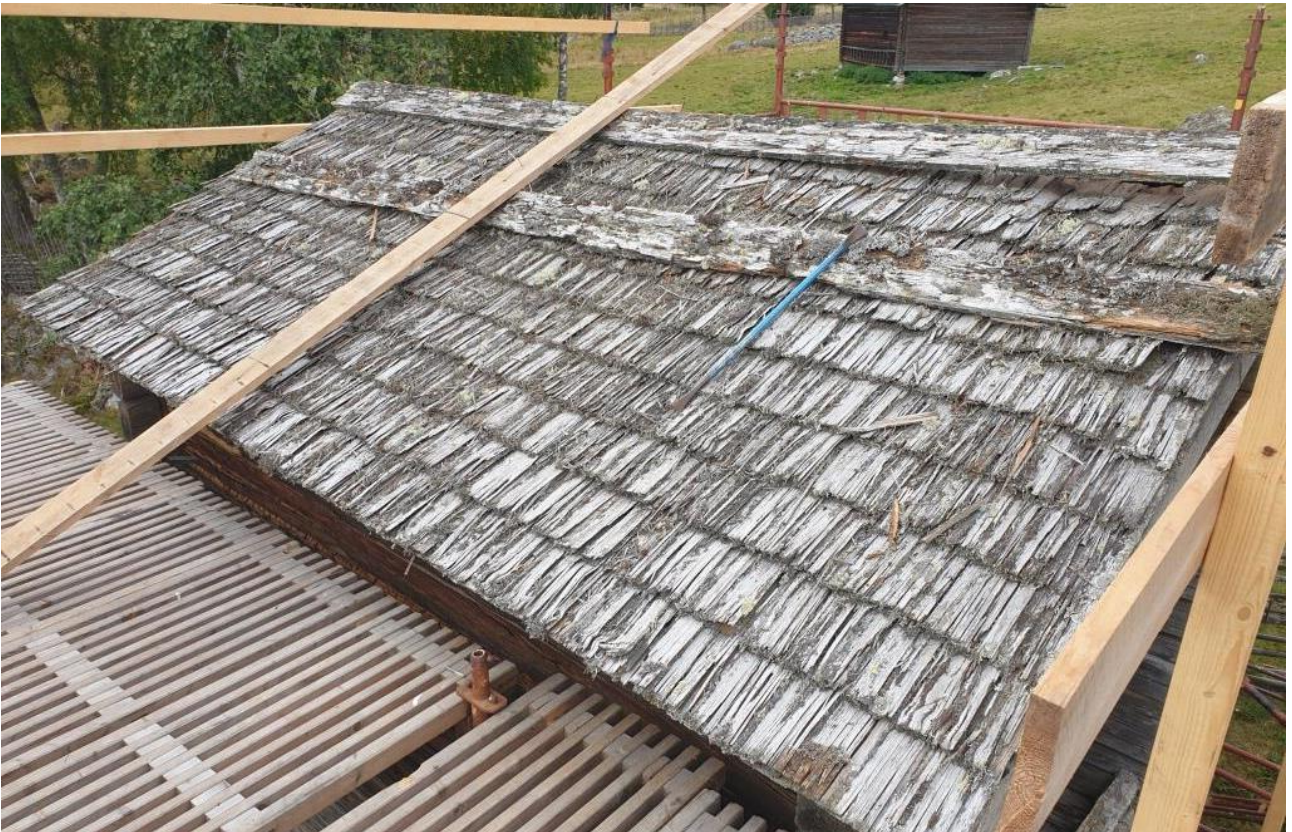
2022-09-09: Det nedre, sydvästra, takfallet ska läggas om. På taket ligger ett furuspån som handspäntats. Virket är taget ur en torraka.
