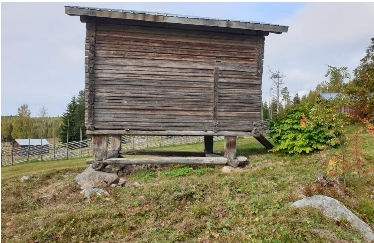
2021-09-18: Ett försök gjordes att rikta härbret 2021 men det lutade fortfarande framåt. Det var instabilt och inte möjligt att räta utan större insatser.
