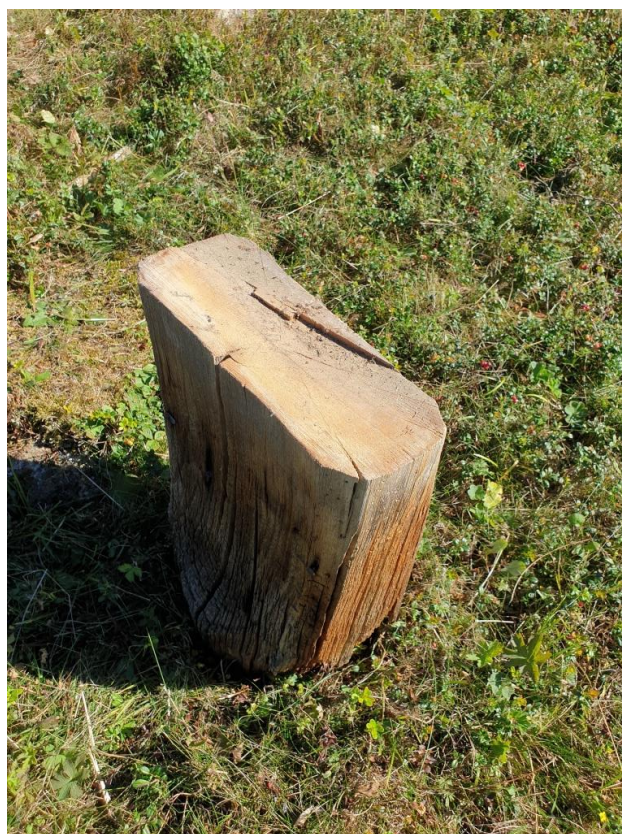
2022-08-24: Stolparna har anpassats med motorsåg vid något tillfälle.
