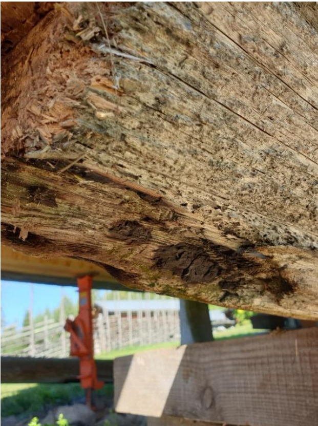
2022-08-24: Syllram B med spår av kol efter brand. Kanske brandskadan hjälpt till att bevara virket?
