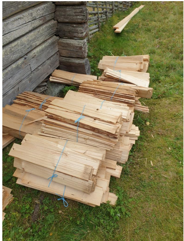
2022-09-09: Härbrets ena sida är omlagd medan arbetet med den andra ska påbörjas. Det nya maskinspantade granspånnet ligger i buntar. Det behöver inte blötas, utan är färskt nog att spikas utan att spricka.
