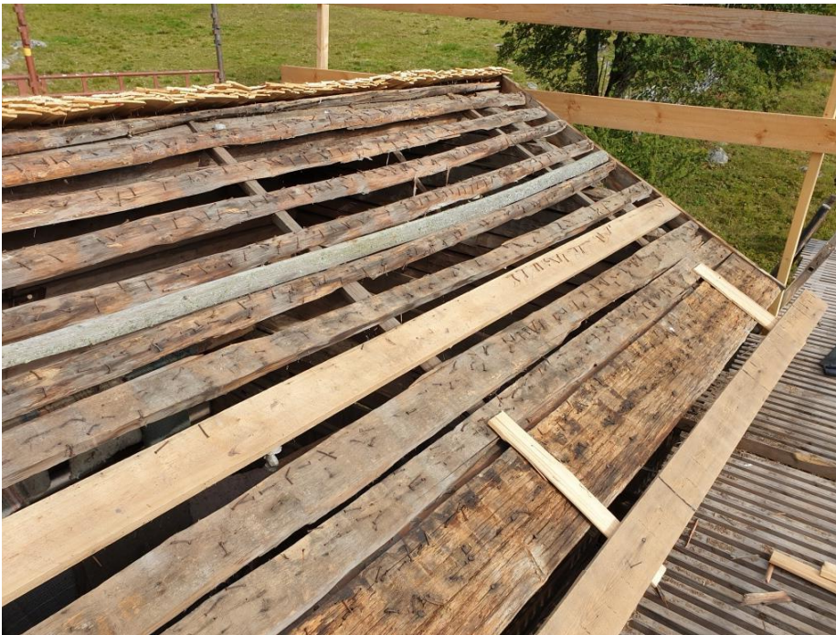
2022-09-10: Spikläkt av äldre, kluvna takbrädor.
