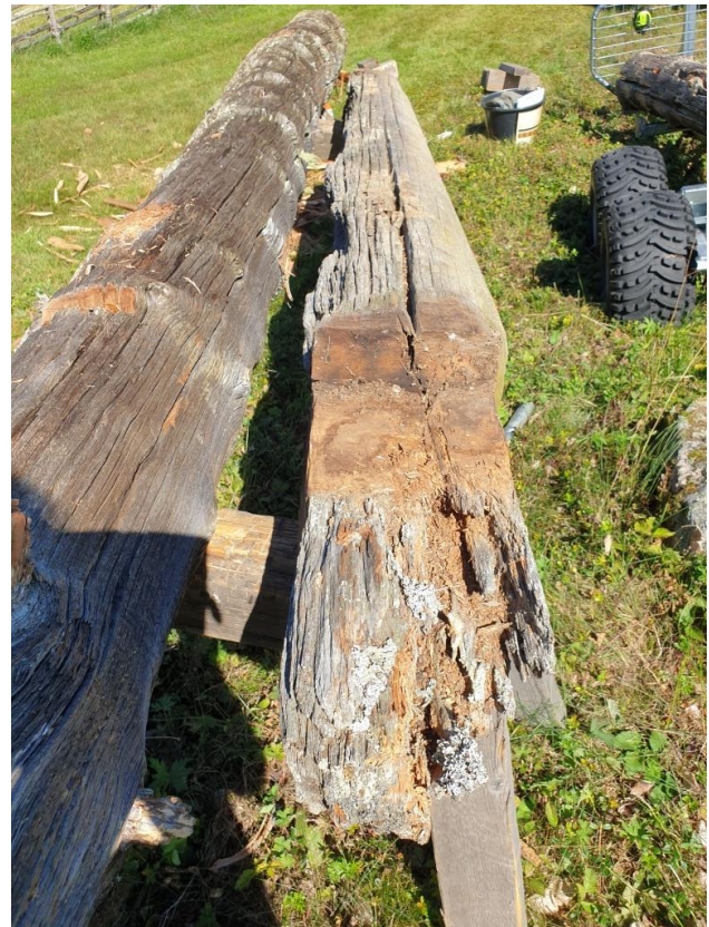
2022-08-24: Syllram C bredvid den ersättningsstock som ska användas.
