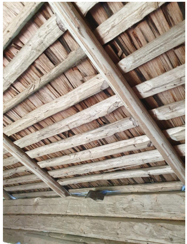
2022-08-24: Handspäntat furuspan i taket.
