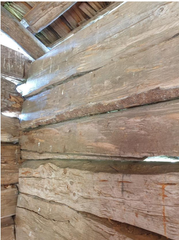
2022-08-24: Höjning av stommen med grantimmer.
