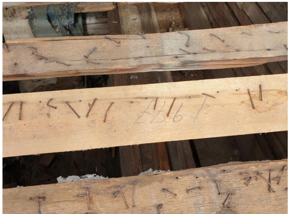
2022-09-10: Årtalet för senaste takomläggningen, 1977, fanns skrivet med blyerts på en nyare bräda. Dagens datum och namnteckningar skrevs på samma bräda innan spånen spikades över.
