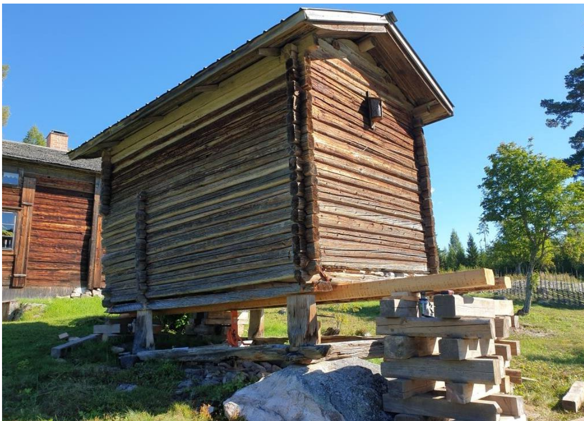
2022-08-24: Härbret pallades upp och lyftes med hjälp av långa timmerbalkar så att stolpar och syllram under gavel C kunde plockas bort.
