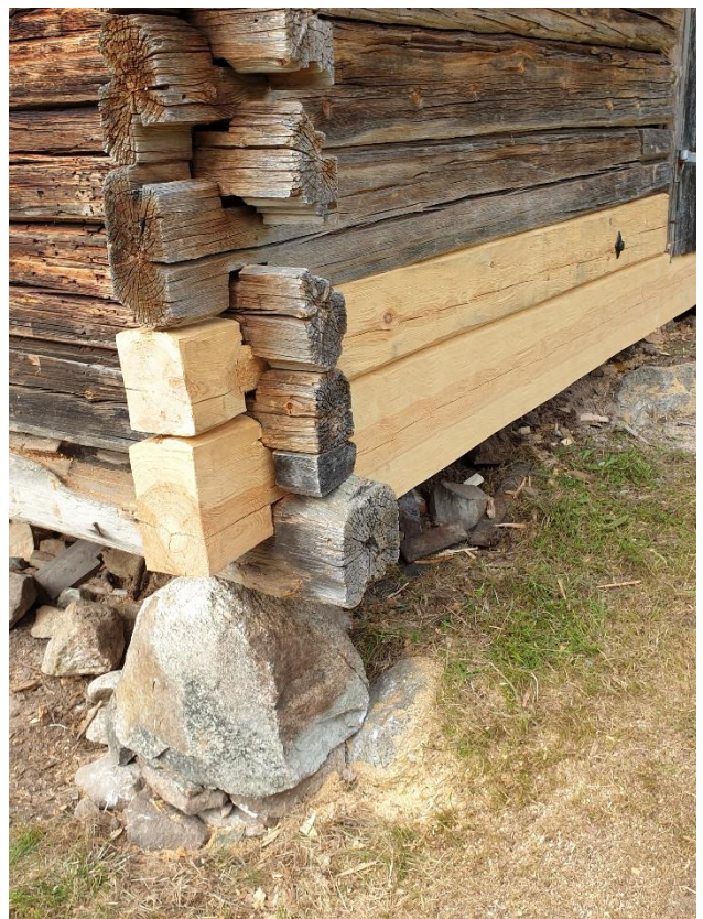
2022-09-09: Slutbesiktning Hörn AB med nytt timmer. Knutändar med huggen yta.
