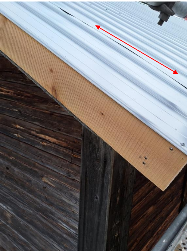
2023-09-15: För att passa utskäftet på gaveln klipps plåten, och kanten viks upp under rillan så att vatten inte ska kunna rinna in trots den vertikala skarven (röd pil).
