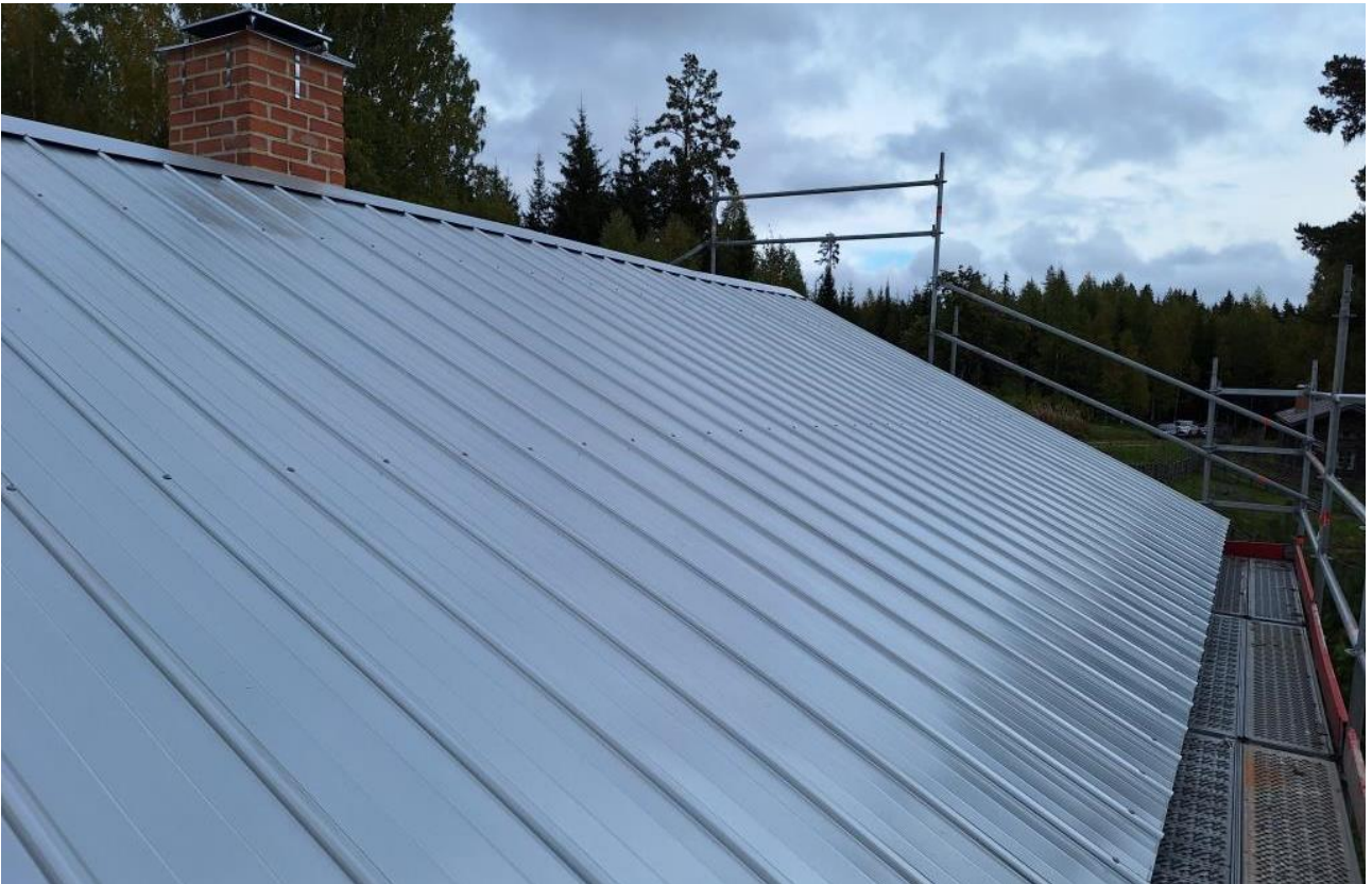
2023-09-15: Södra takfallets pannplåt.
