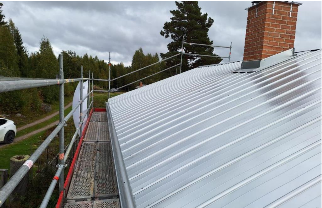
2023-09-15: En ny hänggränna monterades längs hela baksidans takfall, lika som tidigare. Nya skorstensbeslag monterades.
