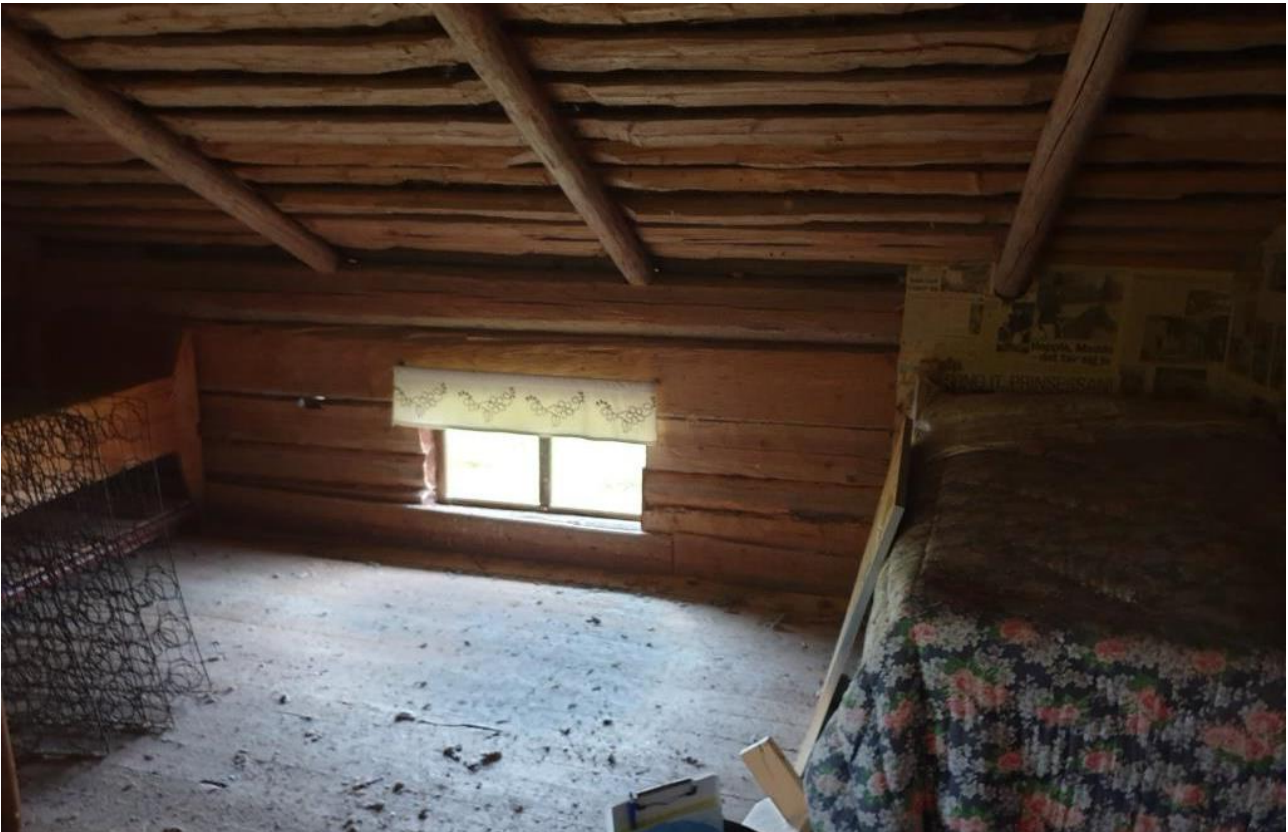
2022-10-13: Lassas vallstuga har en vind som delvis är inredd och delvis är öppen utan skivtäckning. I den öppna delen syntes rötskador i takspånet från 2003.
