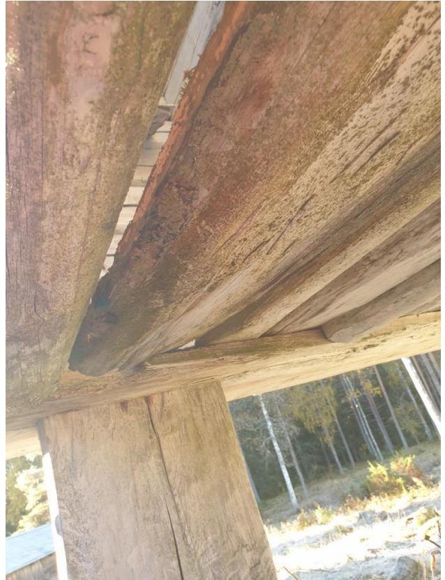
2022-10-04: Den yttre brädan var skadad, medan den inre skulle undersökas närmare innan ev. byte.
