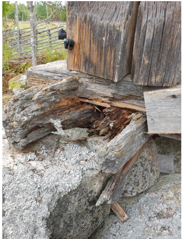
2022-09-09: Rötskadan gör att timret pressas samman.
