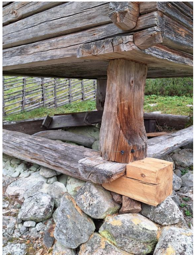
2023-09-15: Återstoden av underredets stock är bevarad.
