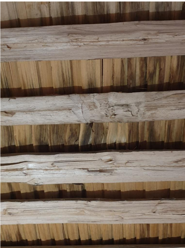
2022-10-13: Splintveden har sugit i sig vatten, och spånen har mörknat av begynnande röta.
