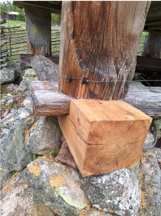
2023-09-15: Underredet har lagats och fått en ny knutskalle.
