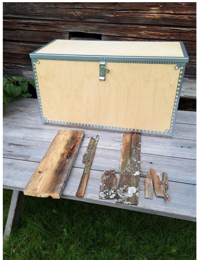
2023-09-15: I arkivlådan har delar från takomläggningen sparats.
