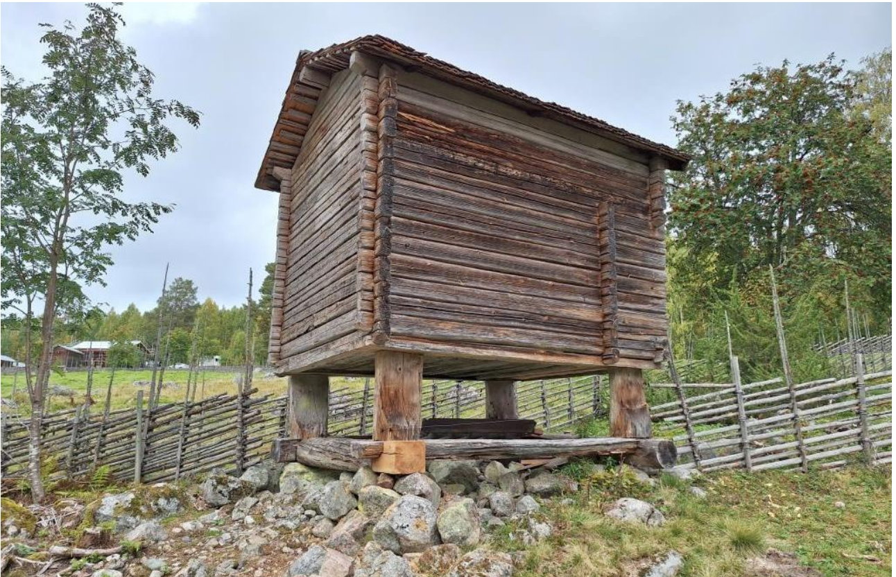
2023-09-15: Härbret på Hagas vall efter lagning av skada och justering av stengrunden.
