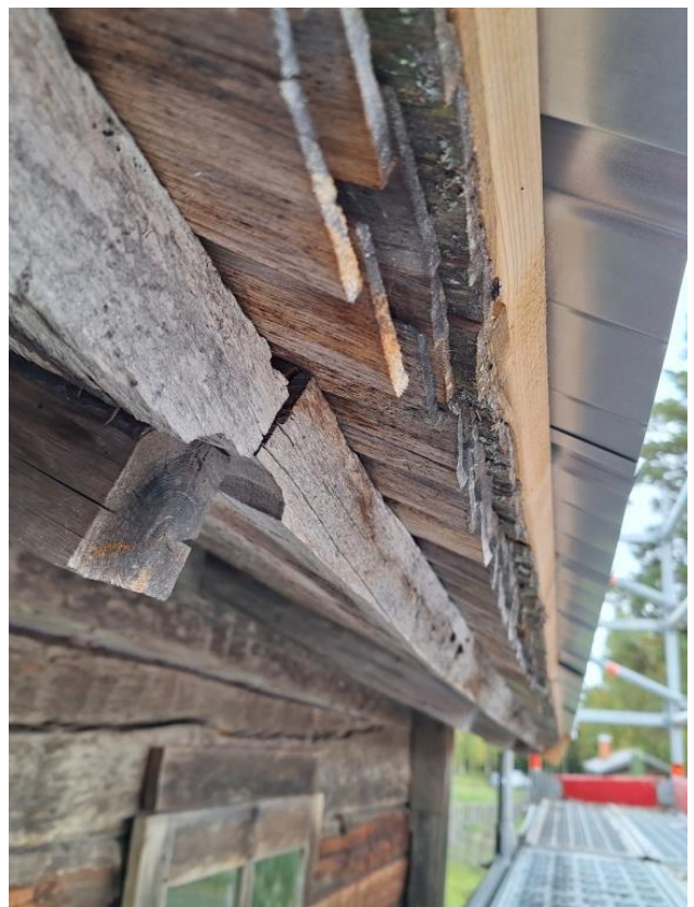
2023-09-15: Plåten har släppts ut ordentligt så att en droppnäså bildas. Några hängbrädor monterades inte, utan hela takupbyggnaden lämnas öppen och synlig.
