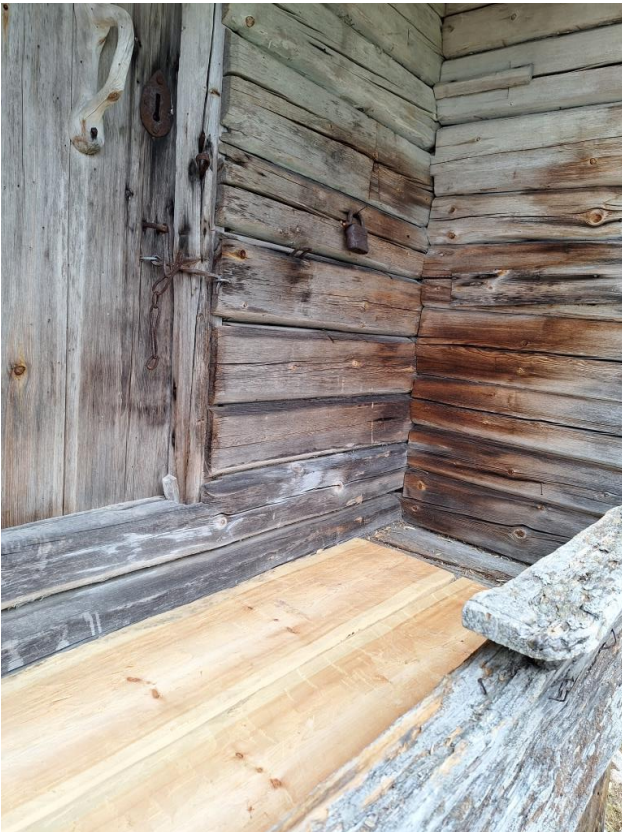
2023-09-15: De tidigare klivbrädorna har ersatts av två nyttillverkade som kluvits fram ur stock och bilats.
