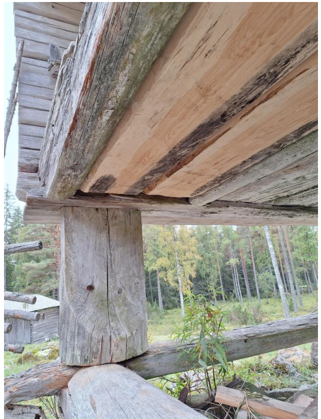
2023-09-15: Klivbrädorna är av furu, lika som de som låg där tidigare.
