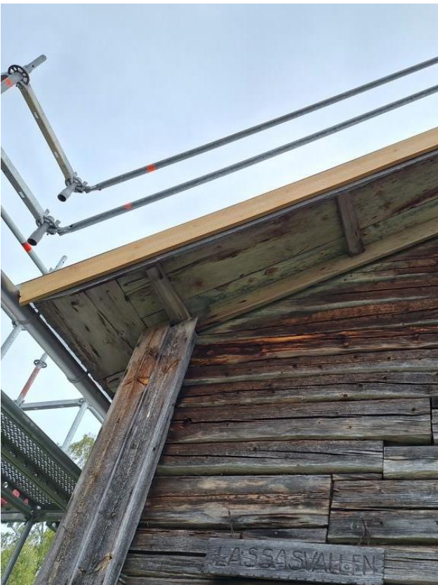
2023-09-15: Takfallen var ur vinkel med någon dryg decimeter så plåtarna fick anpassas för att inte sticka ut i gavelutskäftet.
