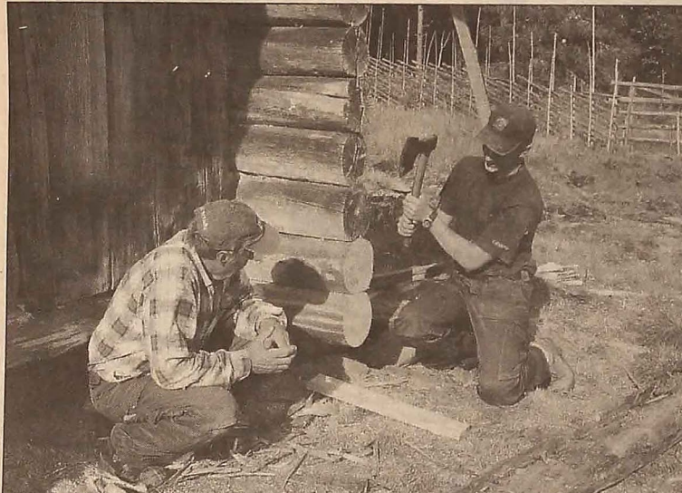
RENOVERING. Olle Ladänges och Anders Johansson från Skogstekniska maskinskolan i Alfta är två av de hantverkare som nu jobbar med att renovera byggnader vid Våsbo fäboddar, med i arbetet finns också folk från Silfors snickeri.
