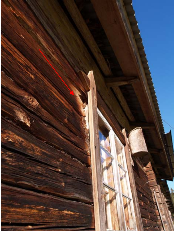
2009-05-06: På Olols stall (ovan samt nere till vänster) var det problem med buktande väggar och att karmen åkt ut (uppe till vänster 081022) och innan bågarna sattes tillbaka så trycktes karmen i läge och spikades fast. Fäxets (nederst) fönster underhölls.
