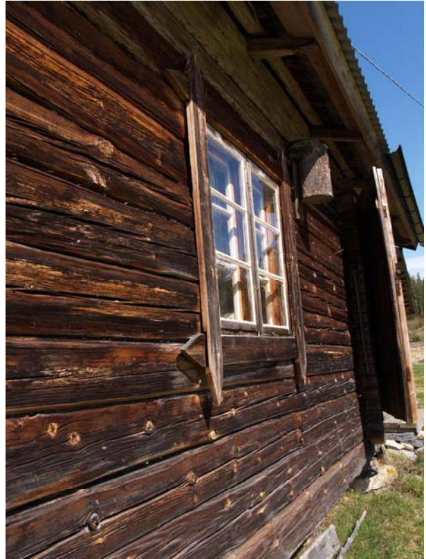
2009-05-06: På Olols stall (ovan samt nere till vänster) var det problem med buktande väggar och att karmen åkt ut (uppe till vänster 081022) och innan bågarna sattes tillbaka så trycktes karmen i läge och spikades fast. Fäxets (nederst) fönster underhölls.
