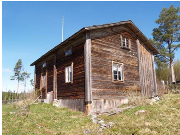
2009-05-06: Lassas stuga har fönster från olika tidsåldrar. Några trälagningar gjordes men främst var det underhåll.
