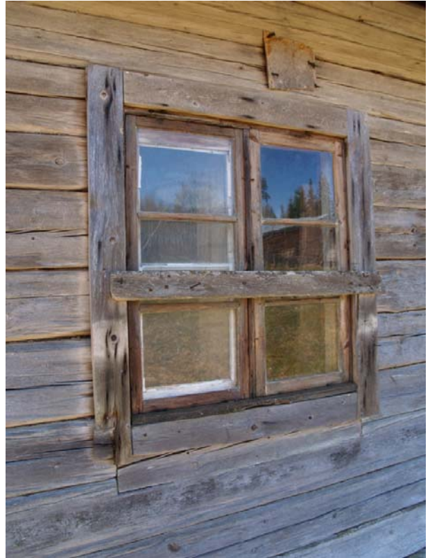
2009-05-06: Stallets bågar har underhållits och skadat virke på baksidans fönster har ersatts med friskt virke.
