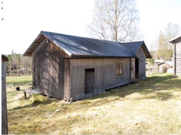
2009-05-06/2009-05-08: Skomakra stallets underhållna fönster.
