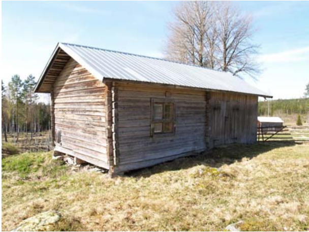
2009-05-06: Stallets bågar har underhållits och skadat virke på baksidans fönster har ersatts med friskt virke.
