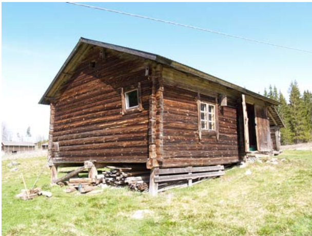
2009-05-06: På Olols stall (ovan samt nere till vänster) var det problem med buktande väggar och att karmen åkt ut (uppe till vänster 081022) och innan bågarna sattes tillbaka så trycktes karmen i läge och spikades fast. Fäxets (nederst) fönster underhölls.
