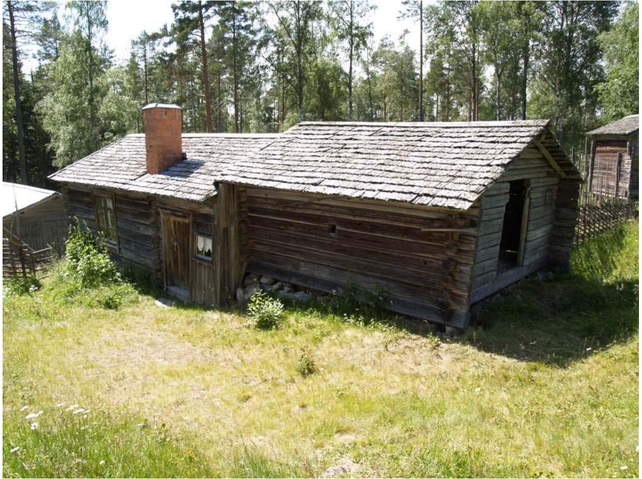
2011-06-28: I samband med justeringen av stengrunden vid källaren lyftes vedboden i hörnet i skarven mellan de två stommarna.
