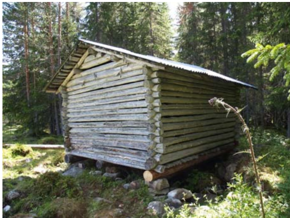
2011-06-28: Ladan har lyft och rötskadade bottenstockar bytts. Grundstenarna har justerats.
