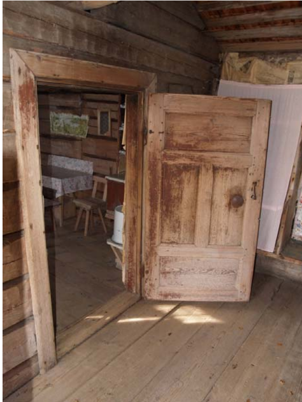
2011-10-11: Stössdörren kan öppnas utan att den tar i golvet. Stenarna vid källarnedgången är upplagda.
