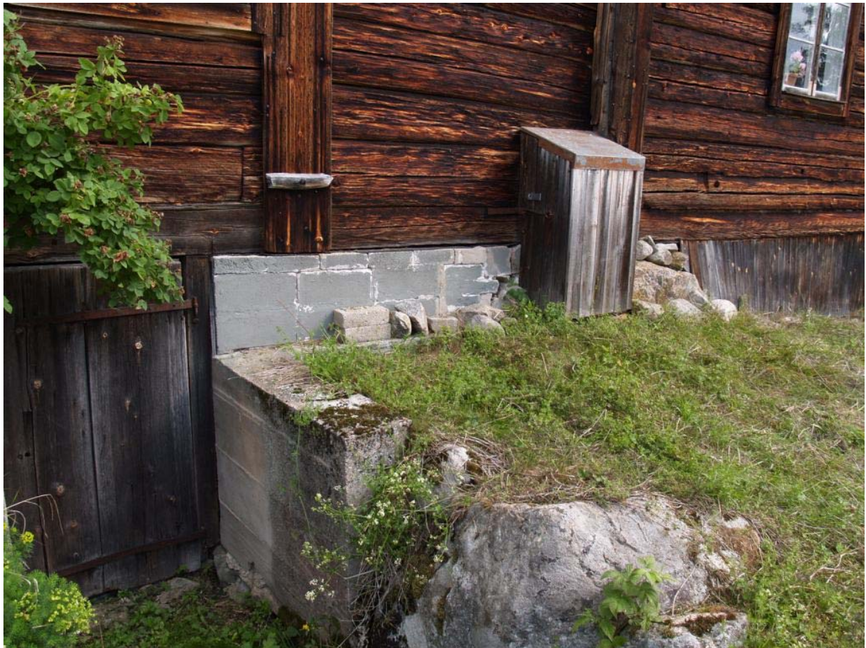
2010-08-03: Innan åtgärd. Den gjutna källarnedgången och grundmuren av cementsten är inte vacker. Sättningar och rörelser i grunden har gjort att muren spruckit och träpanelen har tryckts ut. Lådan inrymmer en gasoltub.
