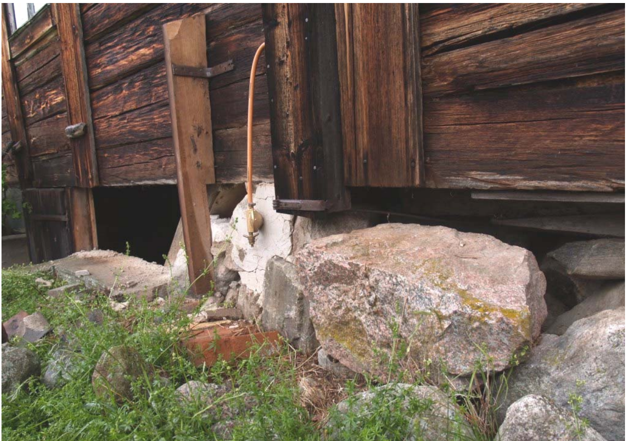
2011-06-13: Arbetet pågår och cementstenen i grundmuren är borttagen.
