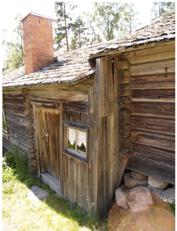
2011-06-28: I samband med justeringen av stengrunden vid källaren lyftes vedboden i hörnet i skarven mellan de två stommarna.
