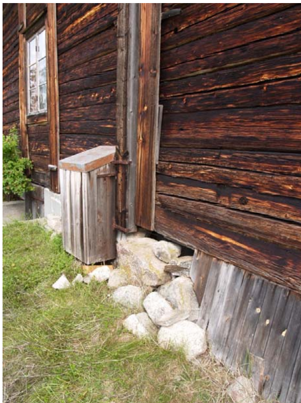
2010-08-03: Innan åtgärd. Den gjutna källarnedgången och grundmuren av cementsten är inte vacker. Sättningar och rörelser i grunden har gjort att muren spruckit och träpanelen har tryckts ut. Lådan inrymmer en gasoltub.
