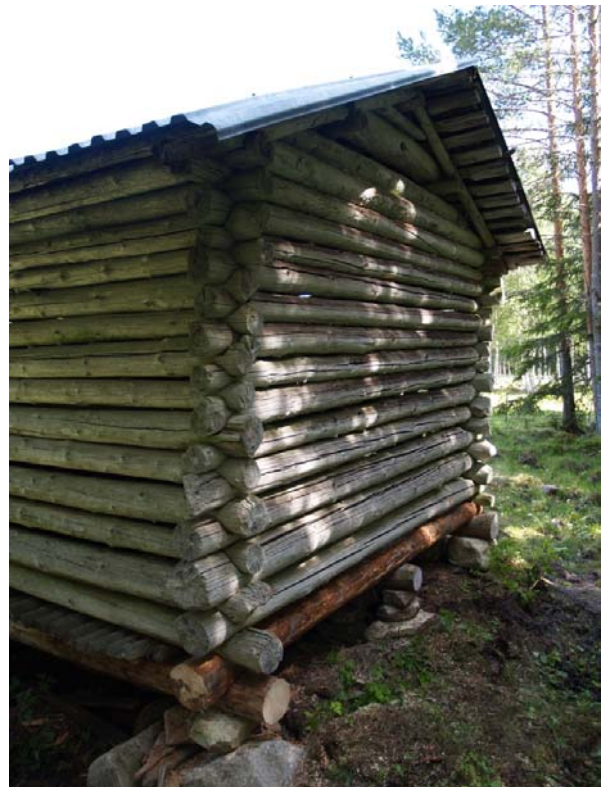
2011-06-28: Ladan har lyft och rötskadade bottenstockar bytts. Grundstenarna har justerats.
