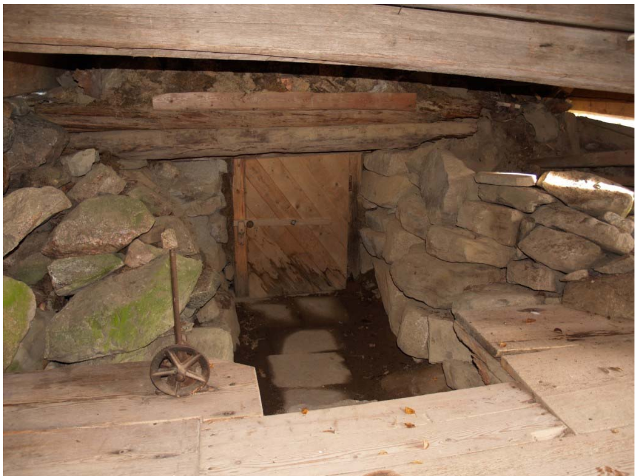
2011-10-11: Stössdörren kan öppnas utan att den tar i golvet. Stenarna vid källarnedgången är upplagda.
