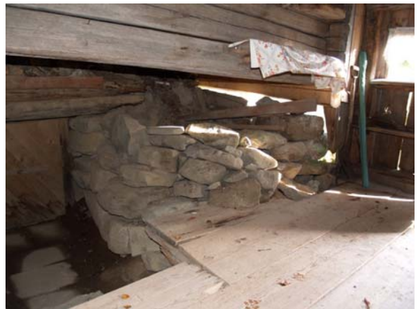
2011-10-11: Stössdörren kan öppnas utan att den tar i golvet. Stenarna vid källarnedgången är upplagda.
