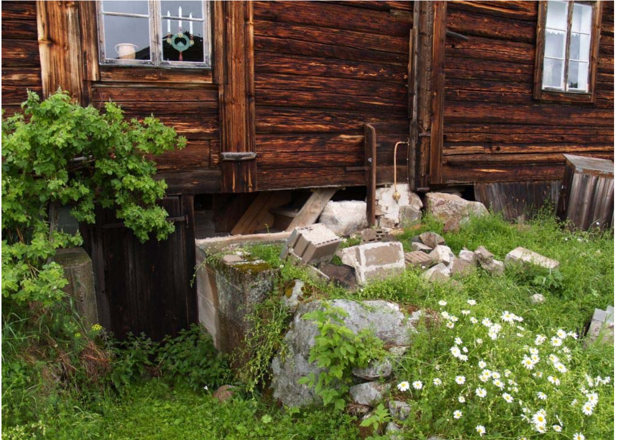
2011-06-13: Arbetet pågår och cementstenen i grundmuren är borttagen.
