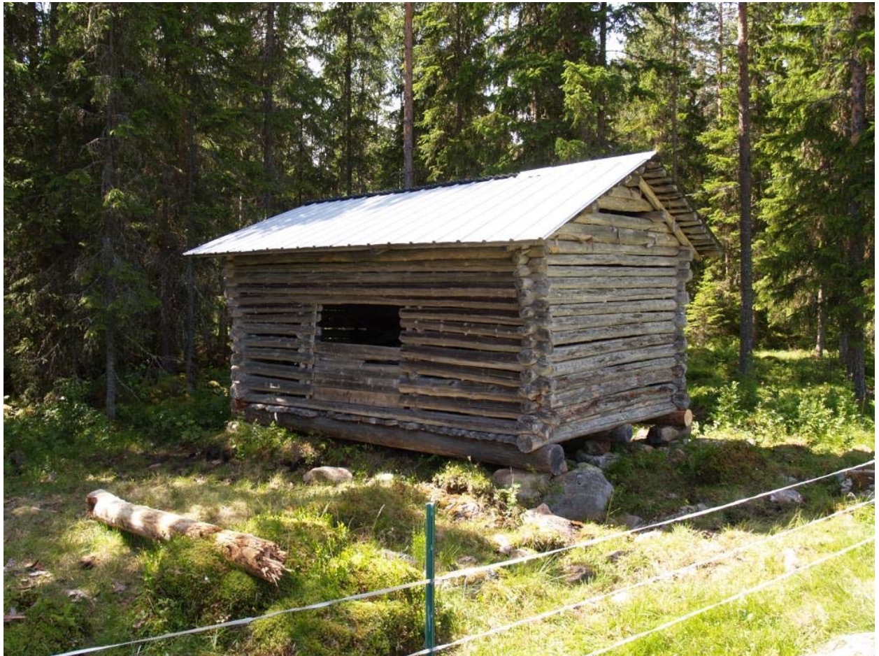
2011-06-28: Ladan har lyft och rötskadade bottenstockar bytts. Grundstenarna har justerats.
