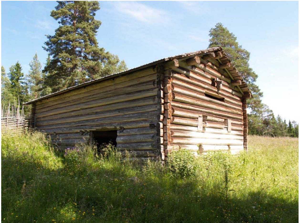
2011-06-28: Grundstenarna har justerats under väggarna.
