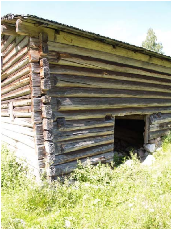
2011-06-28: Grundstenarna har justerats under väggarna.
