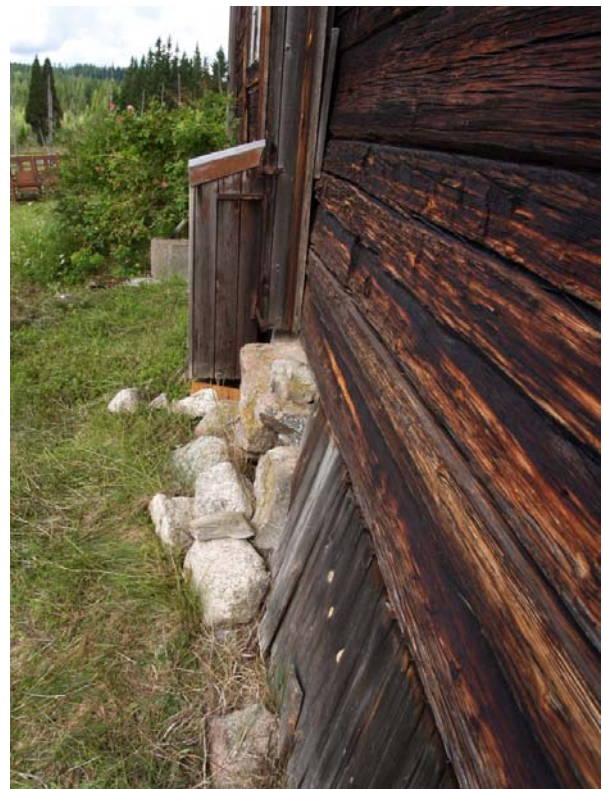
2010-08-03: Innan åtgärd. Den gjutna källarnedgången och grundmuren av cementsten är inte vacker. Sättningar och rörelser i grunden har gjort att muren spruckit och träpanelen har tryckts ut. Lådan inrymmer en gasoltub.
