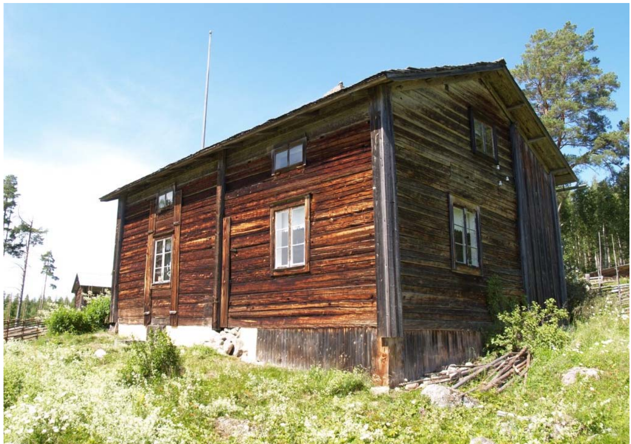
2011-06-28: Arbetet är avslutat och grunden vilar på trästolpar och täcks av en träpanel.
