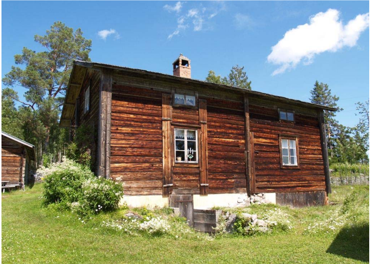
2011-06-28: Arbetet är avslutat och grunden vilar på trästolpar och täcks av en träpanel.
