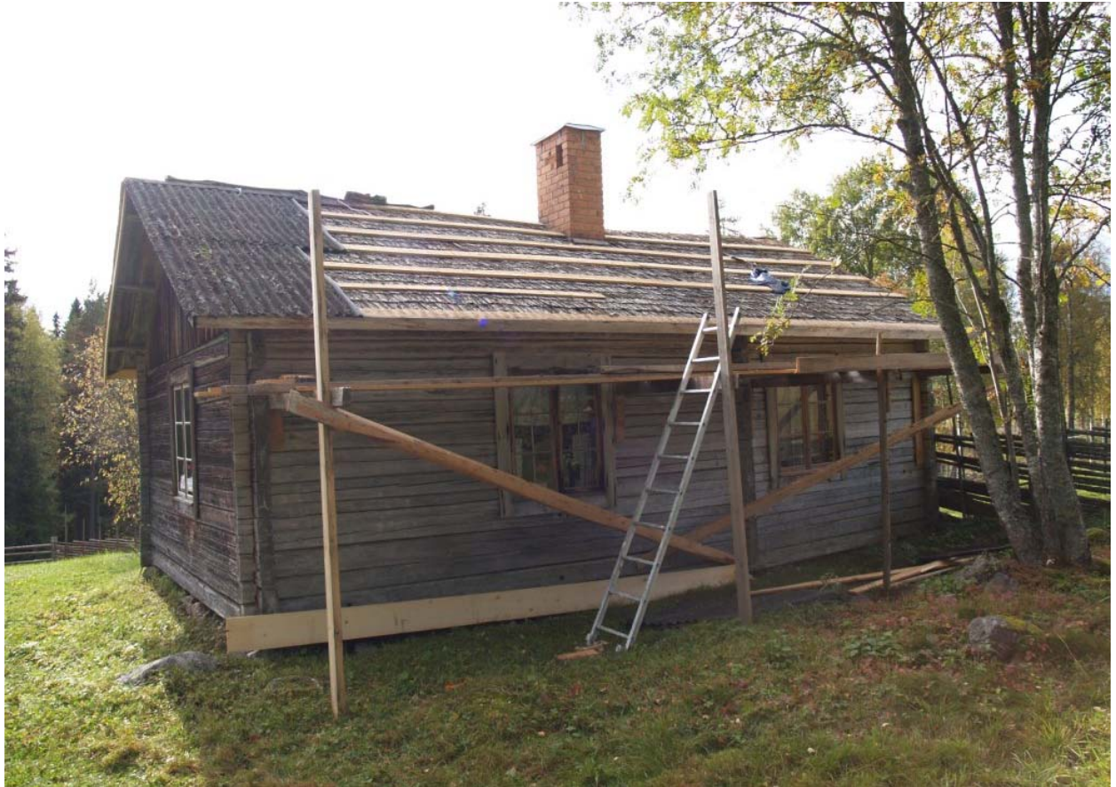
2010-09-22: Arbetet med baksidan har börjat och ondulinen, läkten och det gamla spåntaket ska rivas. Spånen var hyvlad.
