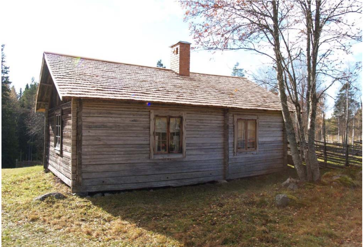
2010-10-11: Baksidans spåntak är klart. Tre lager med handspäntade granspån har lagts. Längst ut i takfoten har virket bytts ut.
