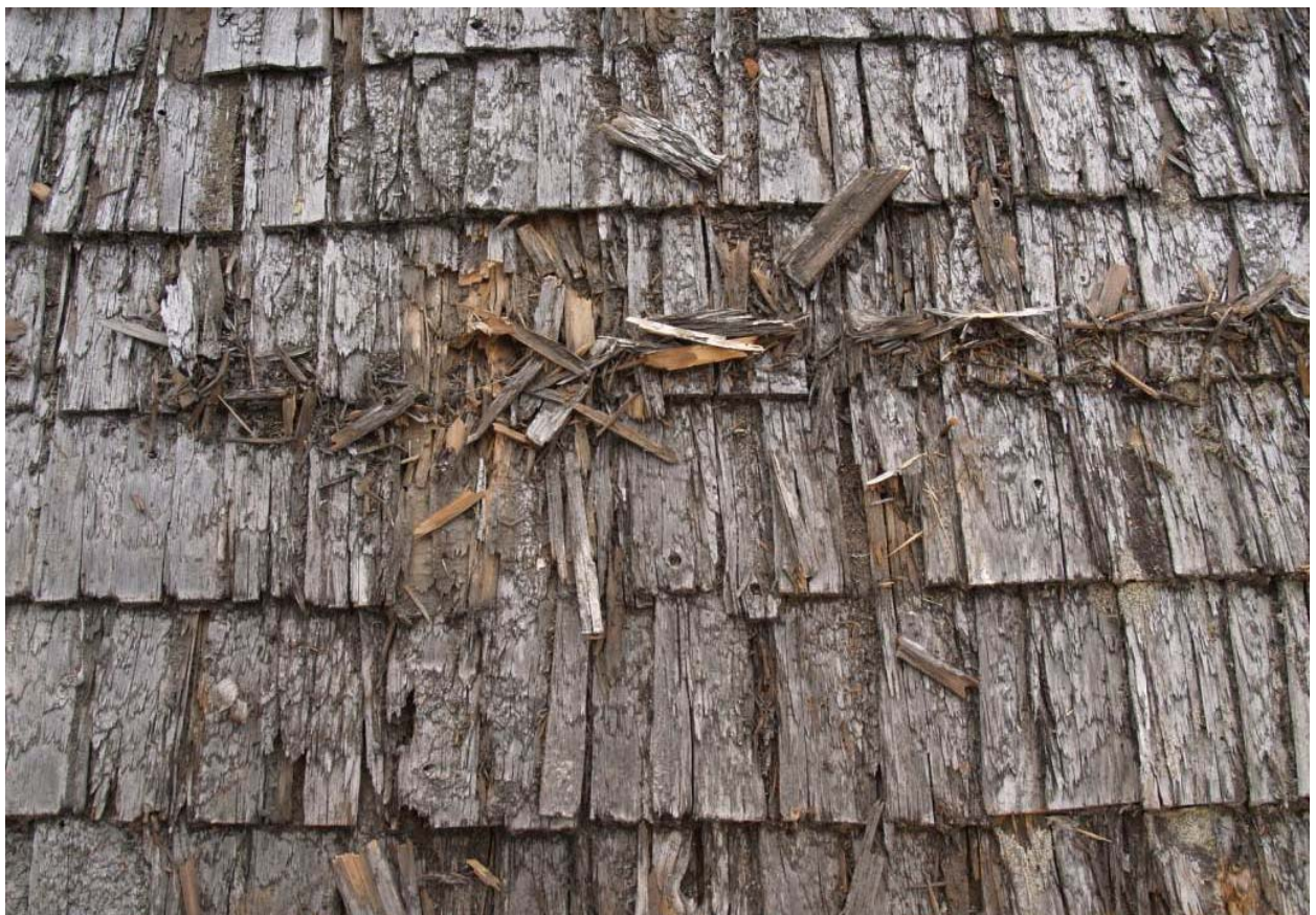
2010-09-22: Arbetet med baksidan har börjat och ondulinen, läkten och det gamla spåntaket ska rivas. Spånen var hyvlad.
