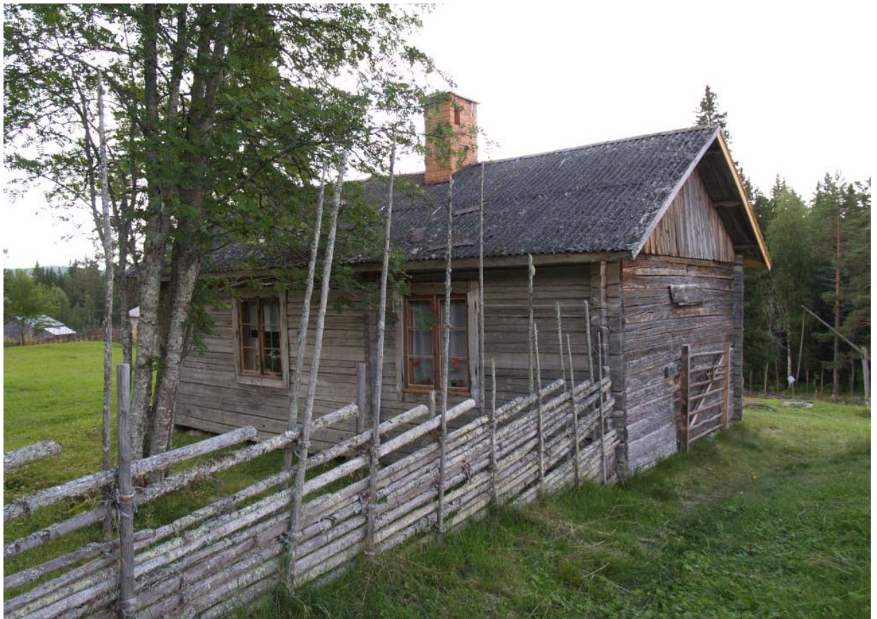
2010-08-03: Till fäbodveckan var framsidans spåntak lagt medan ondulinen låg kvar på baksidan.
