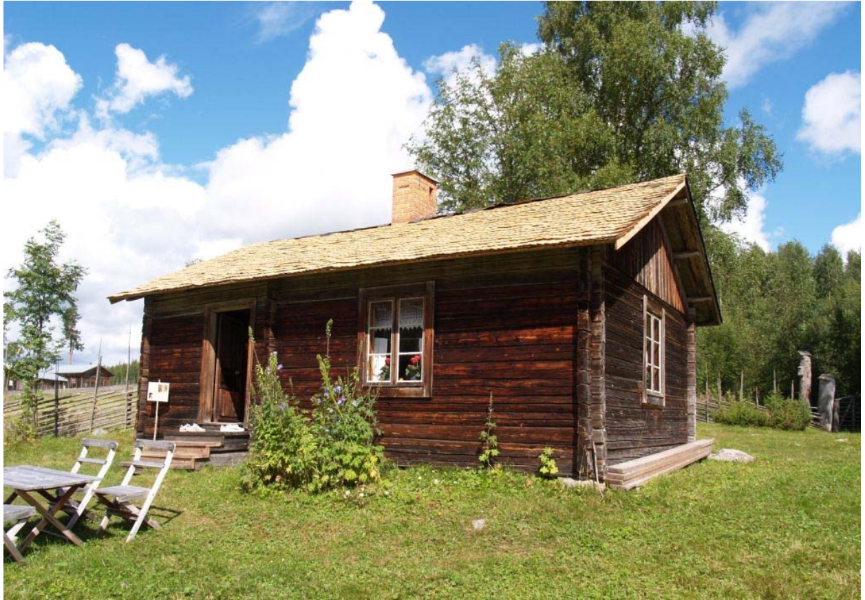
2010-08-03: Till fäbodveckan var framsidans spåntak lagt medan ondulinen låg kvar på baksidan.
