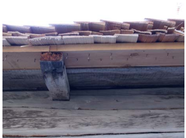
2010-10-11: Baksidans spåntak är klart. Tre lager med handspäntade granspån har lagts. Längst ut i takfoten har virket bytts ut.
