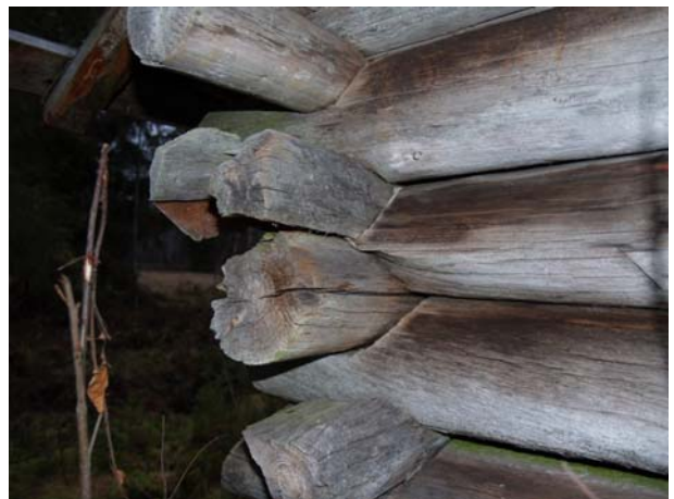
2009-10-28: Krosskador i väggtimmer, sly nära väggen och vattensamlingar bakom ladan har gett skador.
