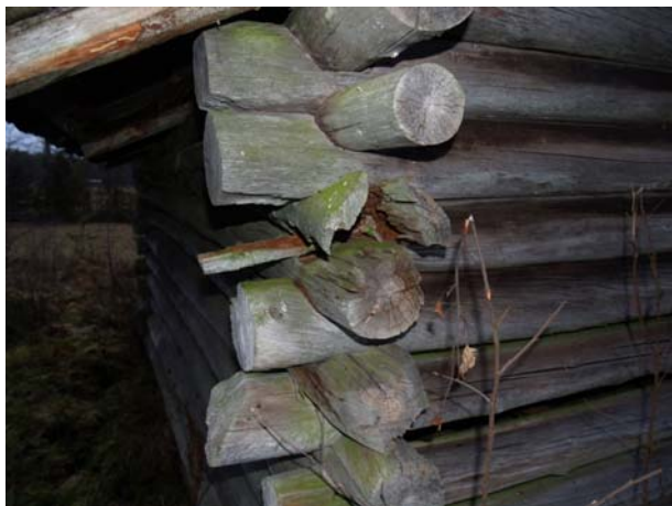
2009-10-28: Krosskador i väggtimmer, sly nära väggen och vattensamlingar bakom ladan har gett skador.
