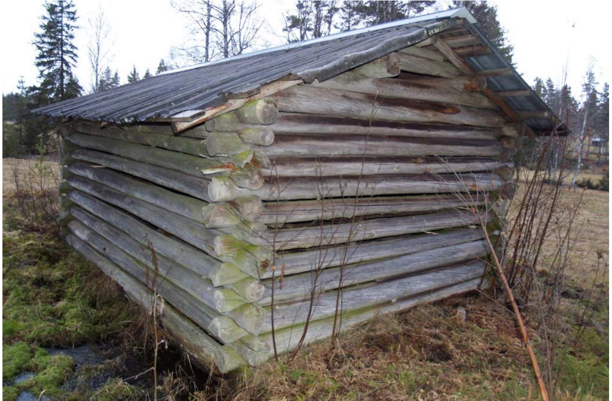
2009-10-28: Krosskador i väggtimmer, sly nära väggen och vattensamlingar bakom ladan har gett skador.
