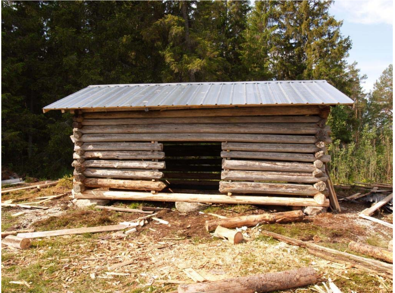
2010-06-29: Tak och grund är åtgärdade.
