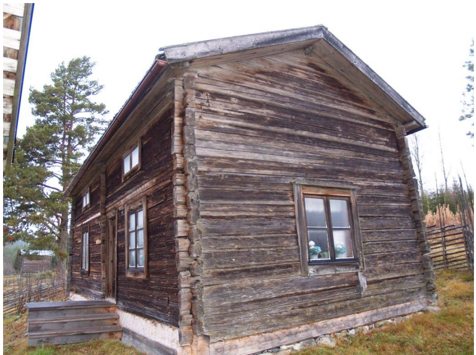
2013-11-01: Vindskivor och vattbrädor kommer också att bytas.
