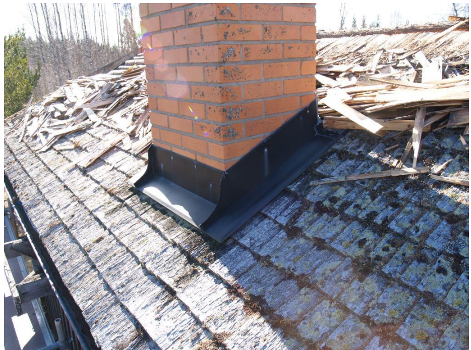
2015-04-21: Befintligt nedre skorstensbeslag.
