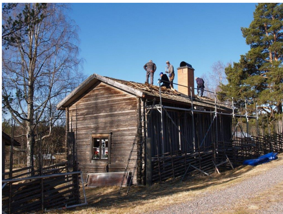
2015-04-21: Arbetet med att skotta bort spån har påbörjats.
