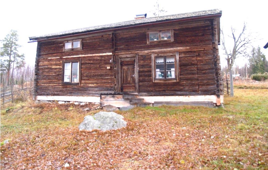
2013-11-01: Skomakras vallstuga har ett spåntak som ska läggas om.
